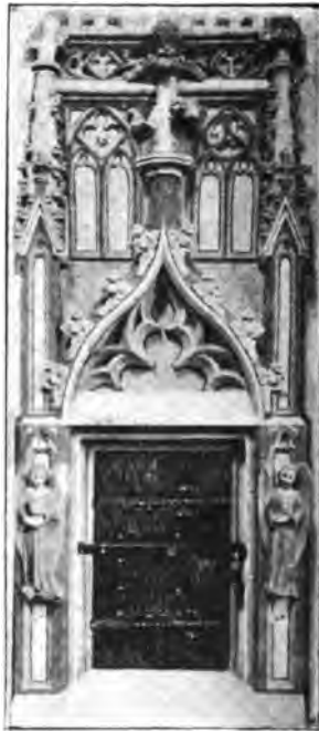
Fig. 9. Sandsteinumrahmung des Sakramentshäuschens.
