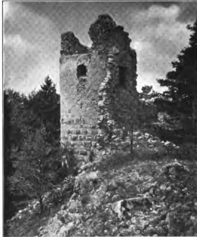
Fig. 45. Ehrenfels. Mauerturm der Burgruine.
