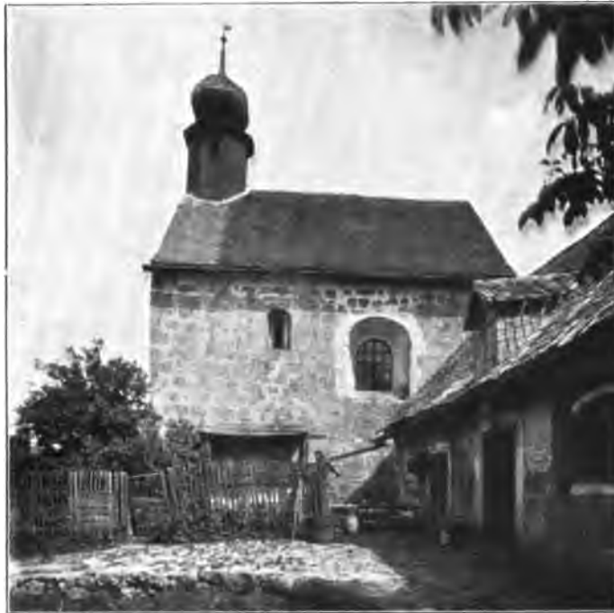
Fig. 180. Schrotzhofen. Ansicht der Kirche von Süden.
