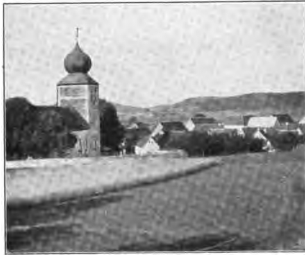
Fig. 161. Pielenhofen. Ansicht der Pfarrkirche von Südwesten.
