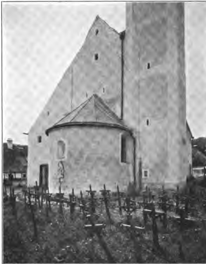
Fig. 143. Oberfraundorf. Ostansicht der Pfarrkirche.
