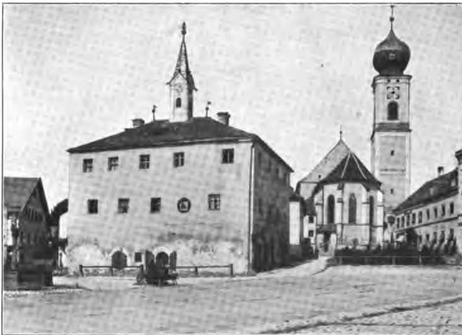
Fig. 82. Hemau. Ansicht des Marktplatzes mit Rathaus und Pfarrkirche.
