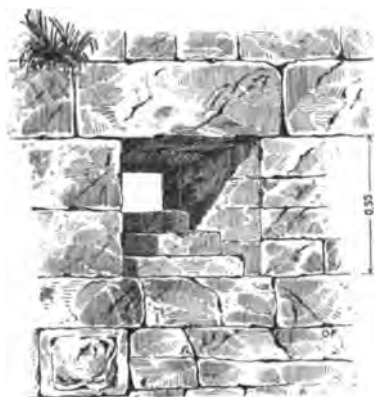
Fig. 46. Ehrenfels. Treppenscharte im Nordturm der Burgruine.
