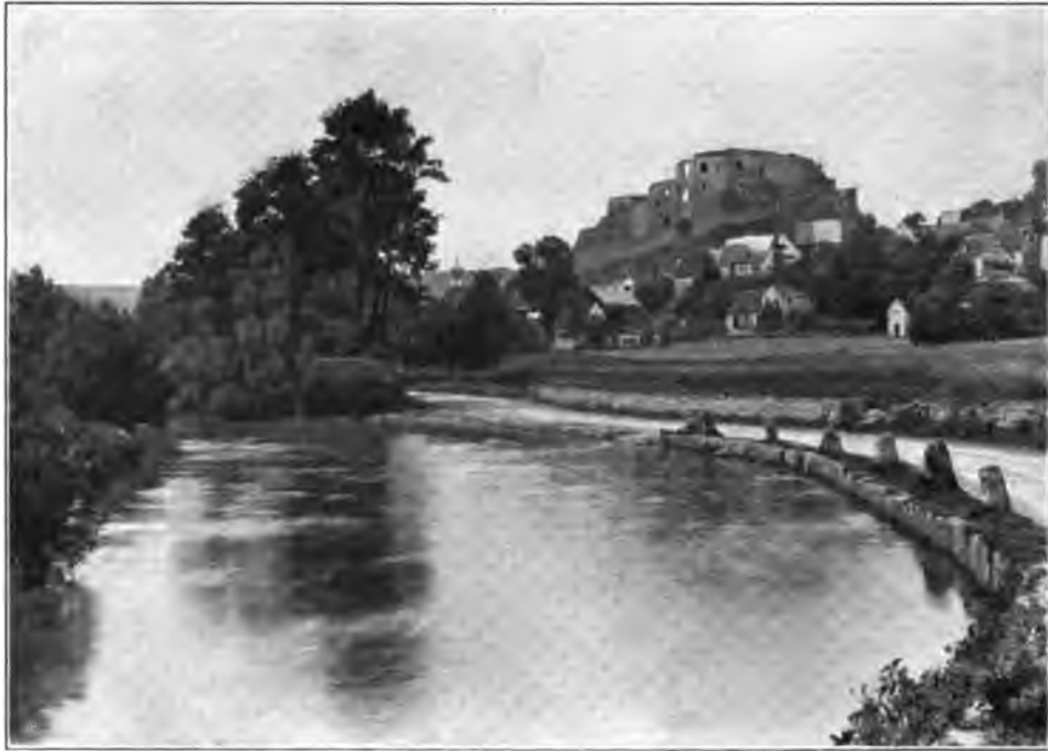
Fig. 122. Laaber. Ansicht der Burgruine von Süden.
