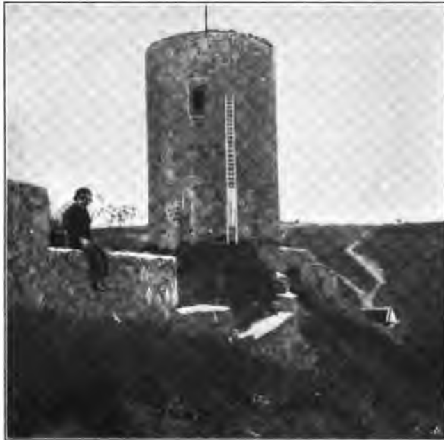
Fig. 103. Hohenfels. Ansicht des runden Bergfriedes von Westen.
