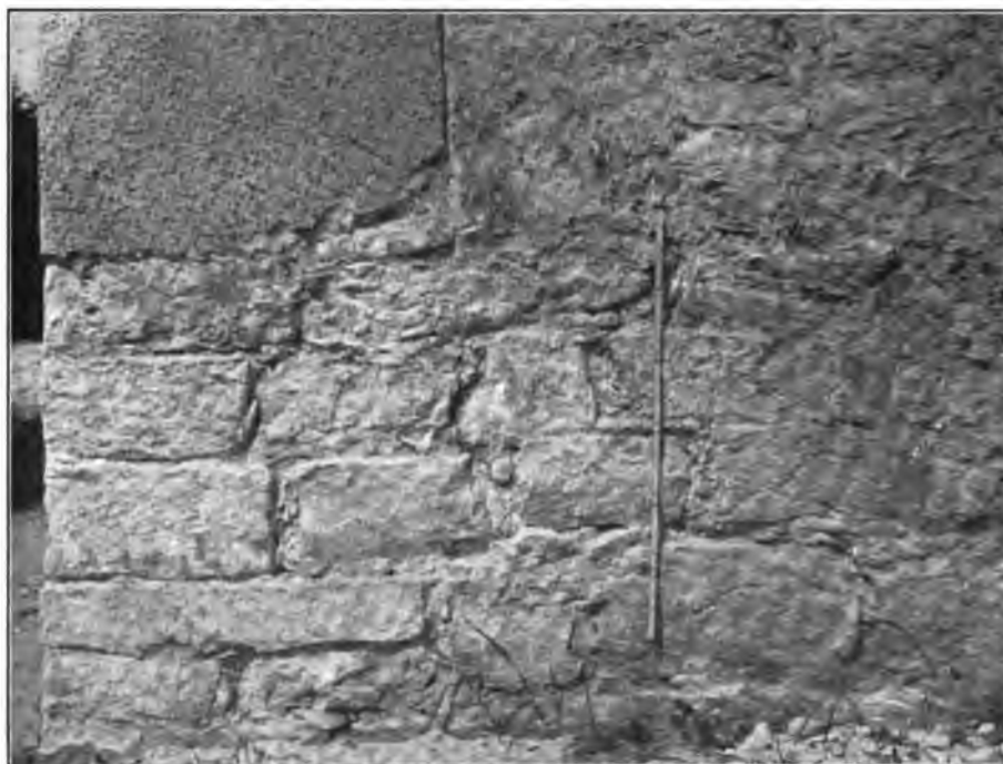
Fig. 127. Premberg. Mauerwerk außen an der Ostseite des Kirchturmes.
