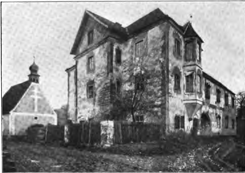
Fig. 97. Schmidmühlen. Ansicht des Zieglerschlusses.
