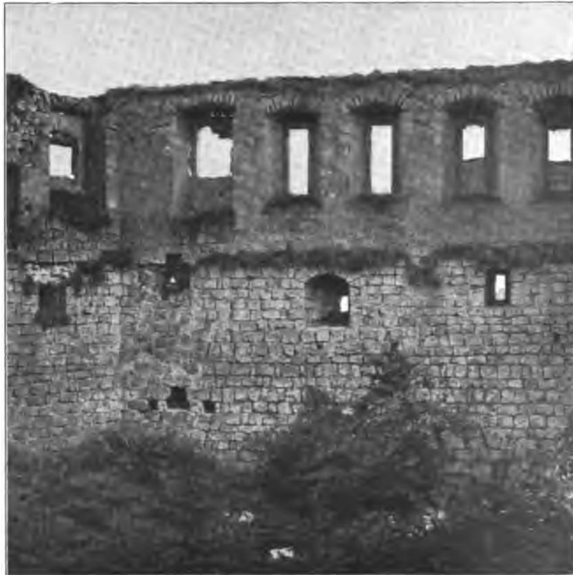
Fig. 58. Kallmünz. Das Innere des Wohnbaues der Burg, 1904.
