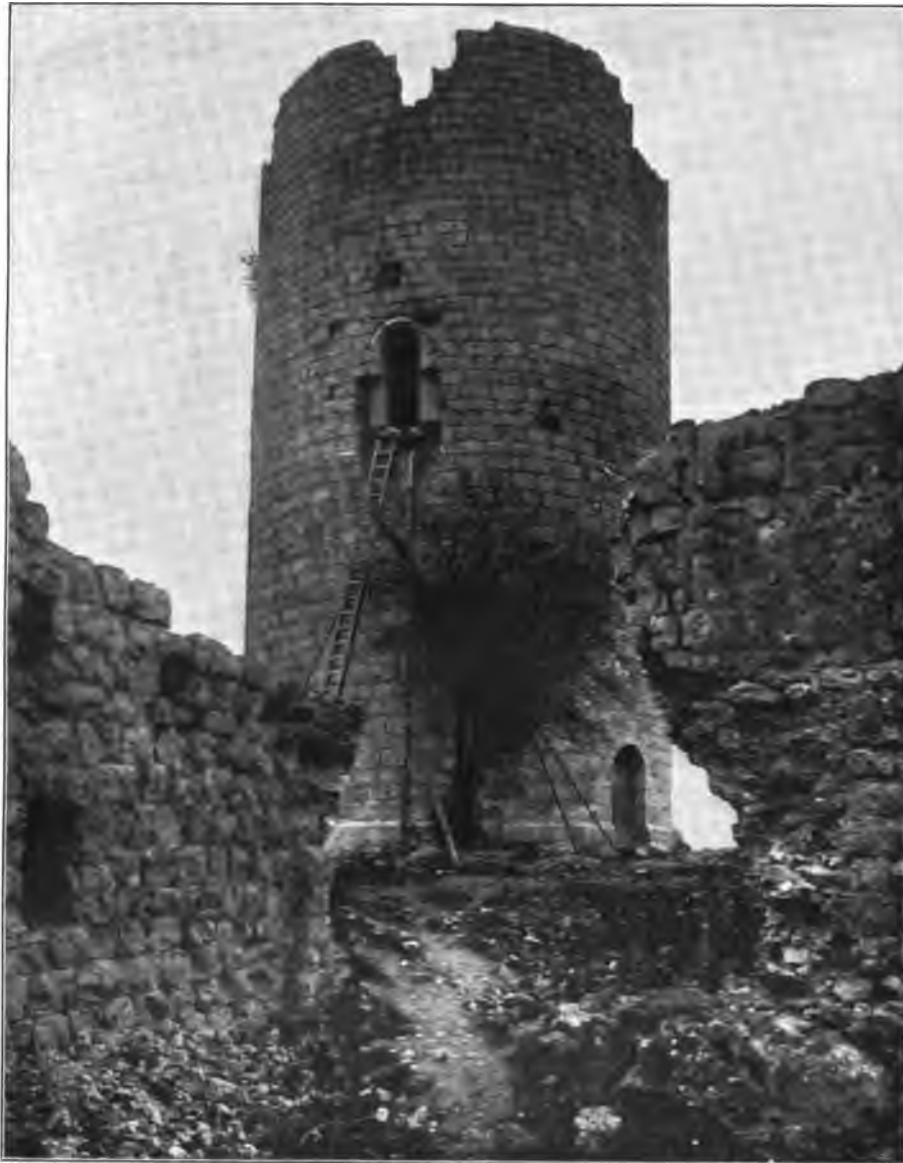
Fig. 53. Kallmünz. Ansicht des Bergfrieds der Burg von Südosten. Restaurierter Zustand 1904.
