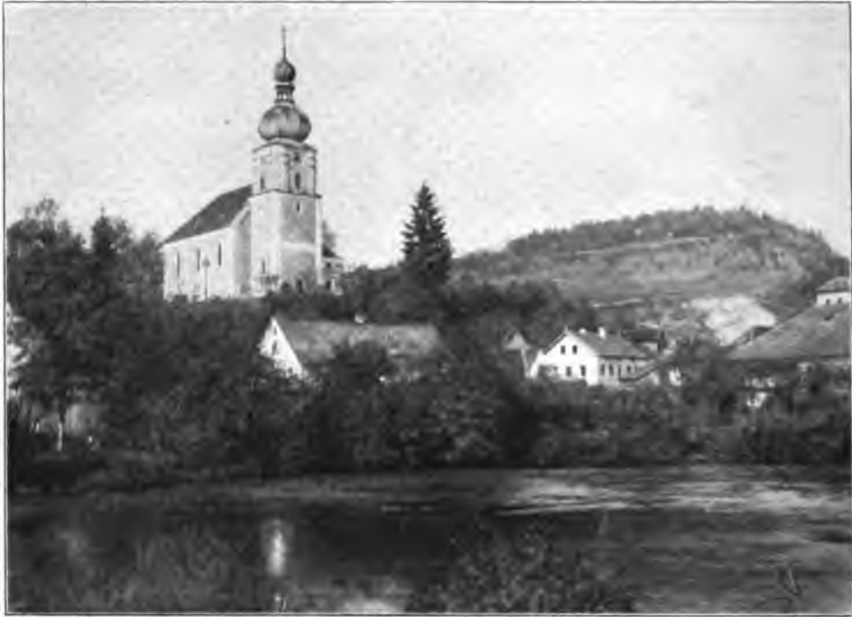
Fig. 24. Dietldorf. Ansicht der Pfarrkirche.
