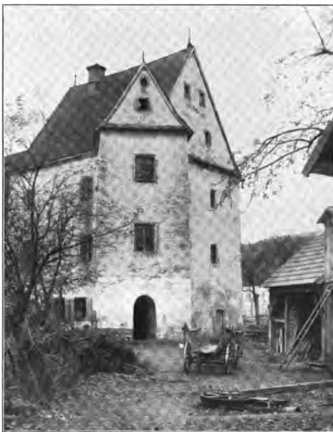
Fig. 89. Rohrbach. Ansicht des ehem. Hammerschlosses.
