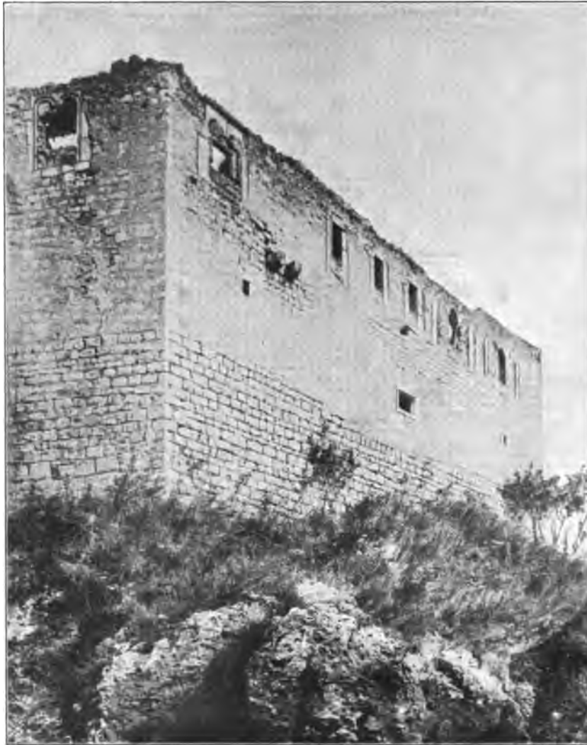
Fig. 56. Kallmünz. Der Wohnbau der Burg, Außenansicht von Süden.
