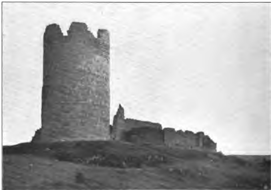
Fig. 54. Kallmünz. Ansicht des Bergfrieds und des Wohnbaues der Burg von Nordwesten, 1904.
