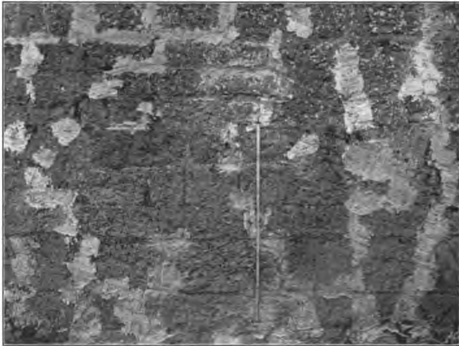
Fig. 126. Premberg. Mauerwerk außen an der Nordseite des Langhauses der Kirche.
