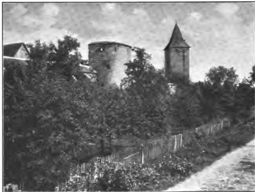
Fig. 37. Berching. Partie an der westlichen Stadtmauer außen, mit Halbturm und Bürgerturm.
