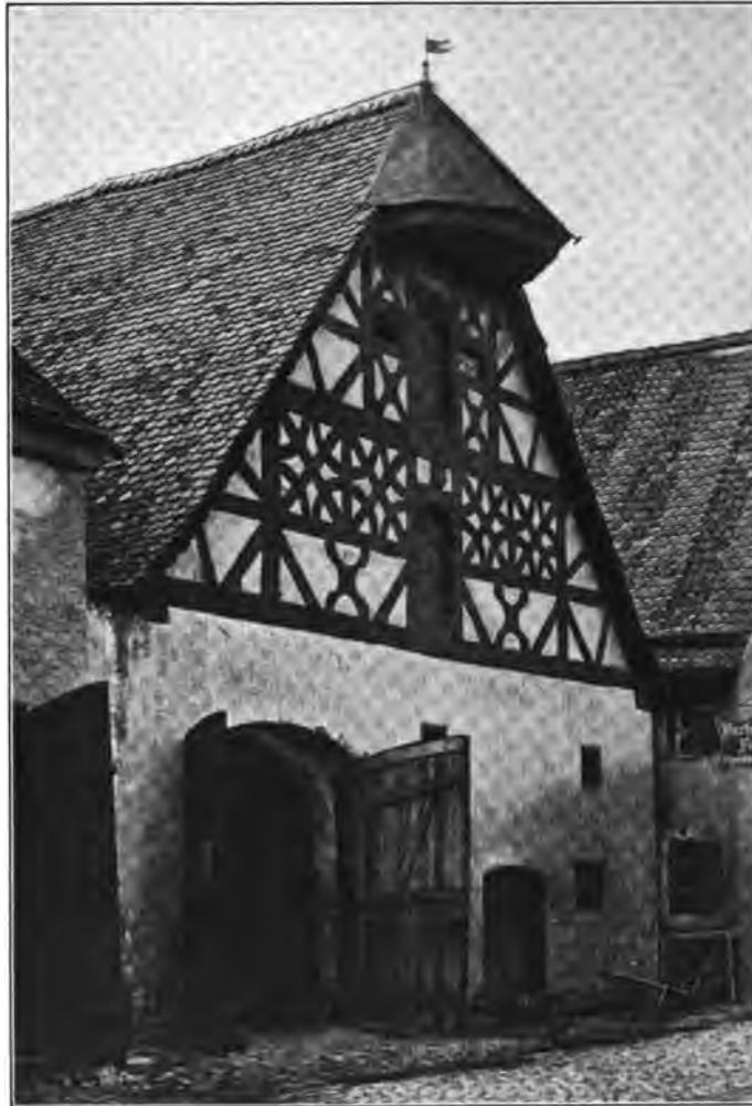
Fig. 58. Berching. Scheune mit Fachwerkgiebel.
