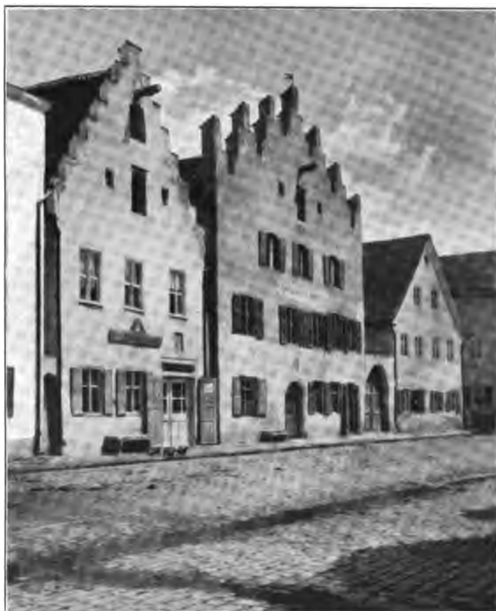
Fig. 13. Beilngries. Häuserpartie am Markt.
