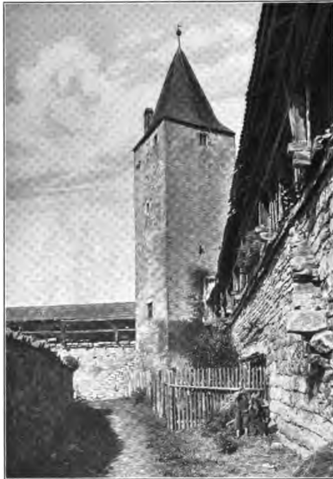
Fig. 39. Berching. Stadtmauer an der Nordwestecke, mit dem Frauenturm.
