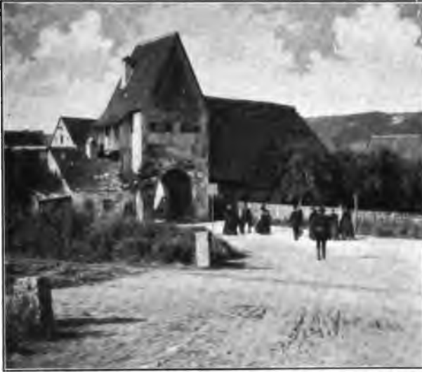
Fig. 51. Berching. Nördliches Vorstadttor (Neumarkter Tor), von außen.
