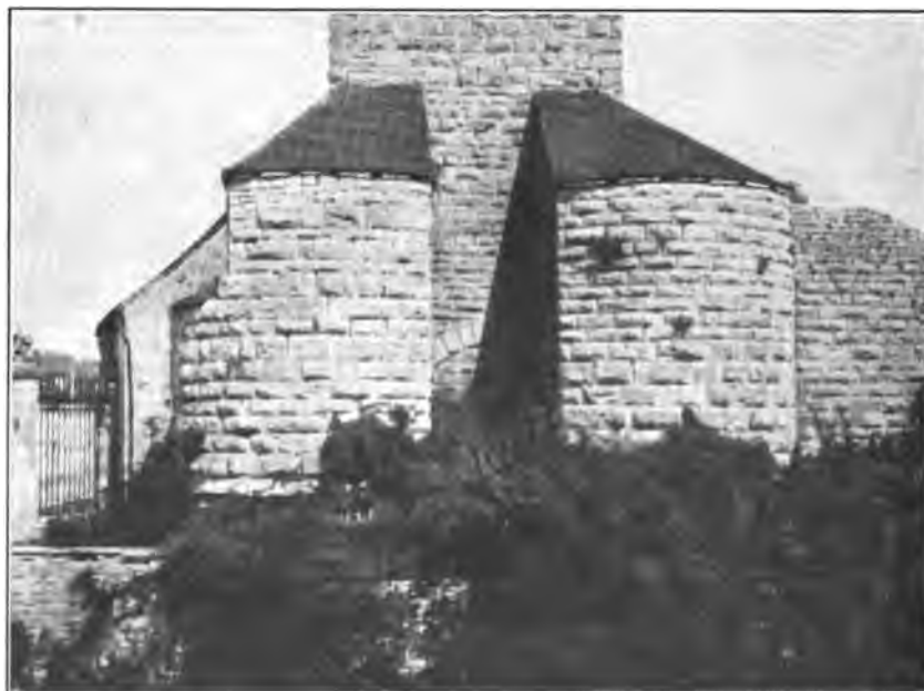
Fig. 74. Hirschberg. Detailansicht vom Torturm.
