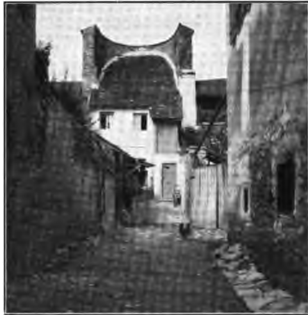
Fig. 45. Berching. Stadtmauerpartie am Halbturm.
