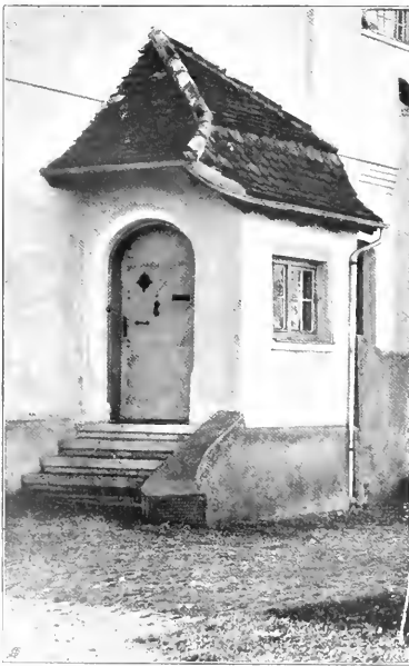
EINGANG ZU VORSTEHENDEM LANDHAUS
