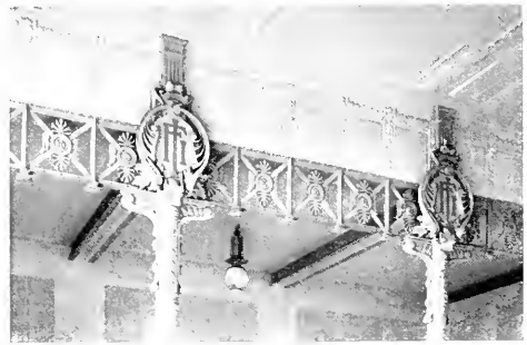
STÜTZEN UND KASTENTRAGER IN STATION MEIDLINGER HAUPTSTRASSE
