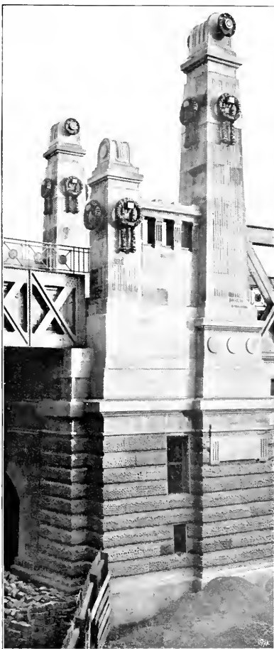
OTTO WAGNER • PFEILER DES STADTBAHN- VIADUKTES ÜBER DAS WIENTHAL
