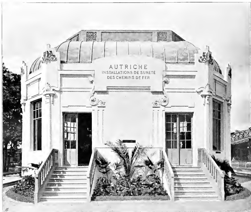
LUDW. BAUMANN, WIEN • PAVILLON DER ÖSTERR. STAATS-EISENBAHNEN AUF DER PARISER WELTAUSSTELLUNG • • •
