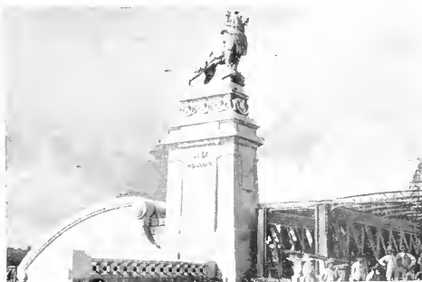
PFELER UND WIDERLAGER AN OBIGEM WEHR
