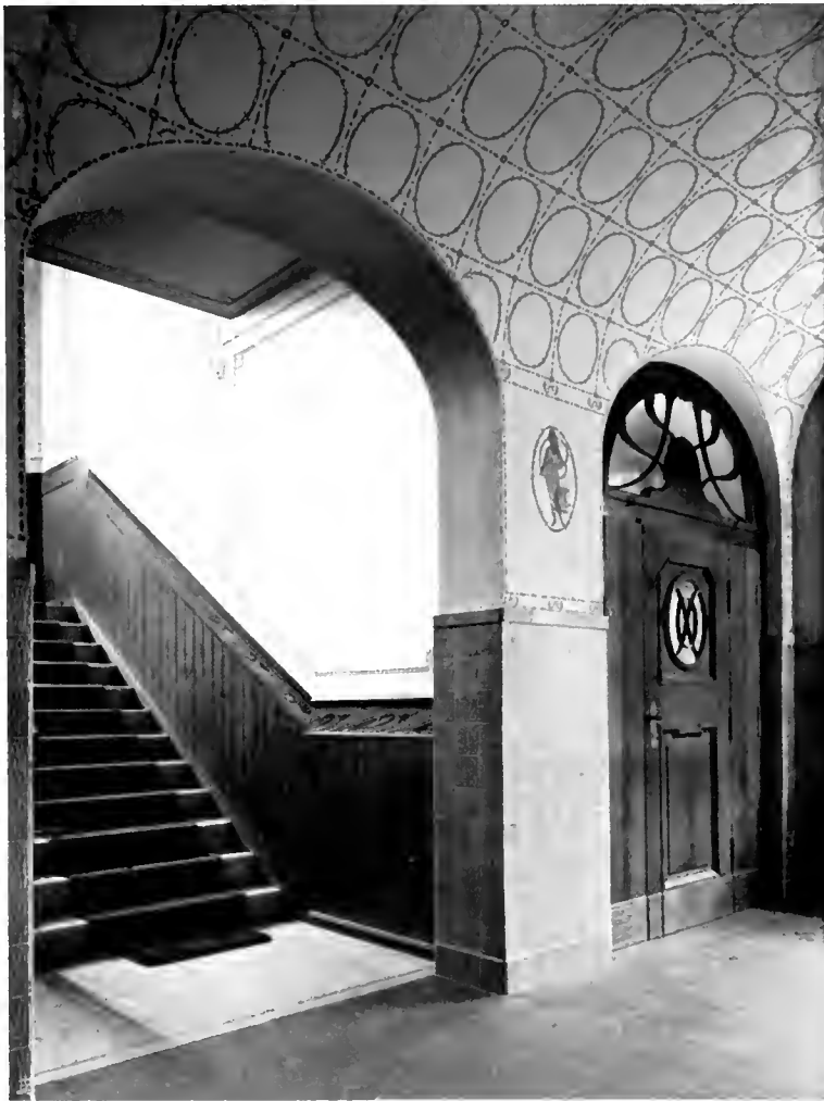
ARCH. KURT HAGER ■ LANDHAUS STAPF-MÖBIUS: BLICK INS TREPPENHAUS
