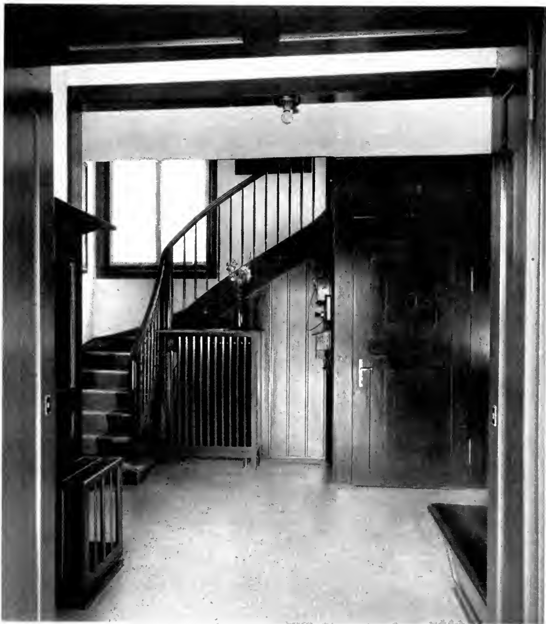
ARCH. RITTMAYER & FURRER-WINTERTHUR □ □ HAUS RITTMAYER, BLICK VON DER HAUSTÜR IN DEN FLUR Grün gestrichenes Tannenholz
