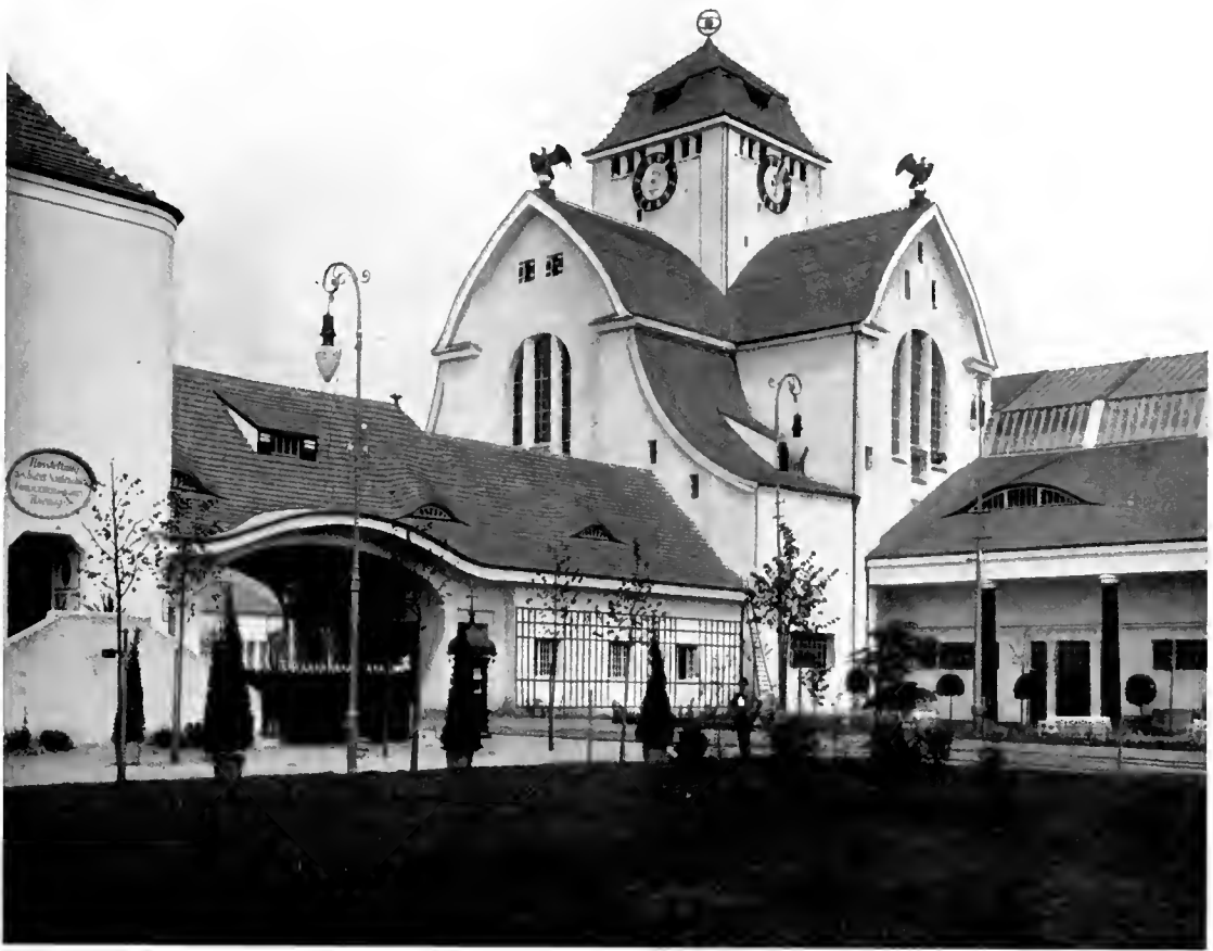
ARCH. EMANUEL VON SEIDL-MÜNCHEN □ DAS DEUTSCHE HAUS: RÜCKSEITE UND VERBINDUNGSGANG ZUM WEINRESTAURANT (LINKS); RECHTS KRAFTMASCHINEN-HALLE
