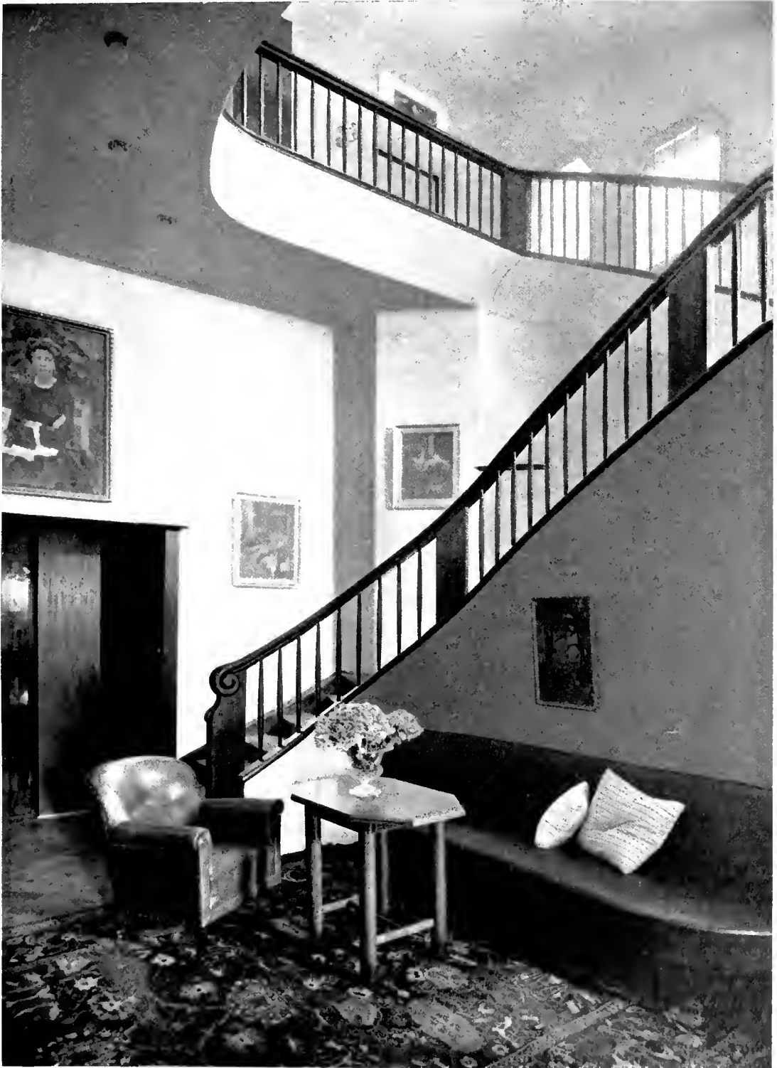
ARCH. PROF. EMANUEL VON SEIDL-MÜNCHEN □ □ HAUS BRAKL: TREPPENHAUS, GERÄUCHERTE EICHE
