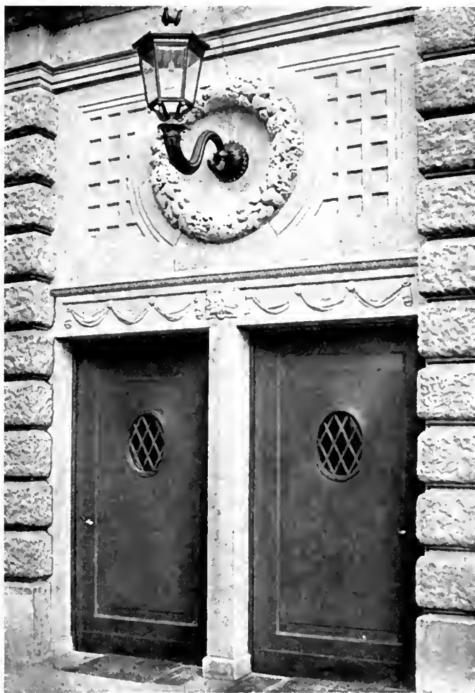
ARCH. P. BIRKENHOLZ ■ WOHNHAUS IN ZÜRICH: HAUSTÜR
