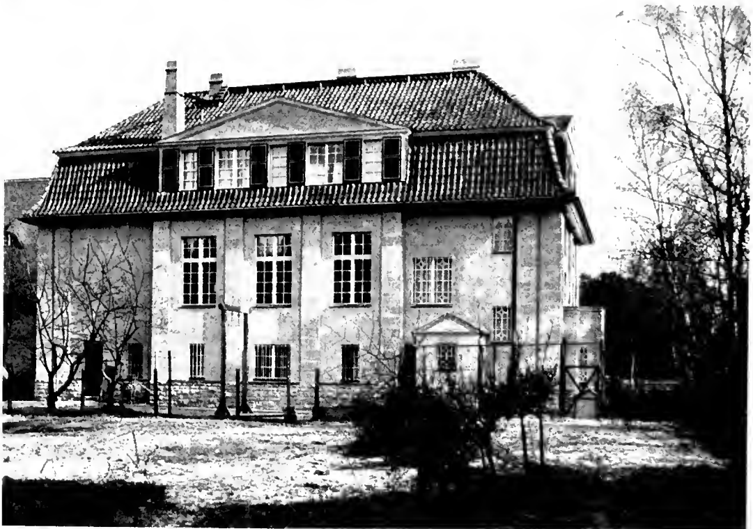
ARCH. HERMANN MUTHESIUS-NIKOLASSEE HAUS GAFFRON IN SCHLACTENSEE BEI BERLIN (Grundr. s. nebenstehend)
