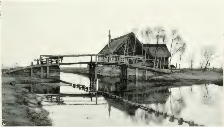
Abb. 123. Brücke über den Moorkanal. (Zu Seite 117.)
