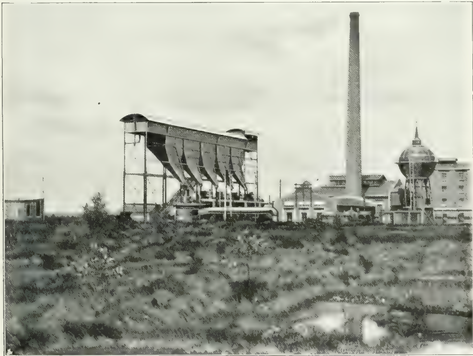
Abb. 46. Elektrisches Kraftwerk im Großen Moor bei Schwega. (Zu Seite 51)
