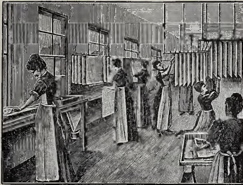
Fig. 46. Schwimmenlassen des Papieres auf dem flüssigen Albumin.
