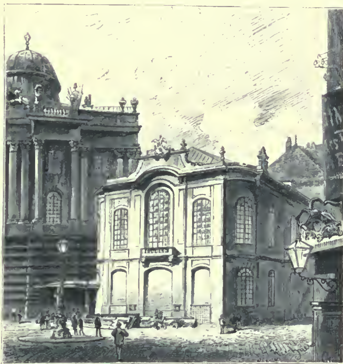
Das alte Burgtheater am Michaelerplatz in Wien.
