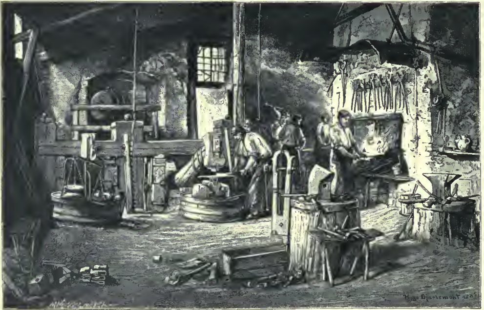
Das Innere einer alten Hammermiede.
