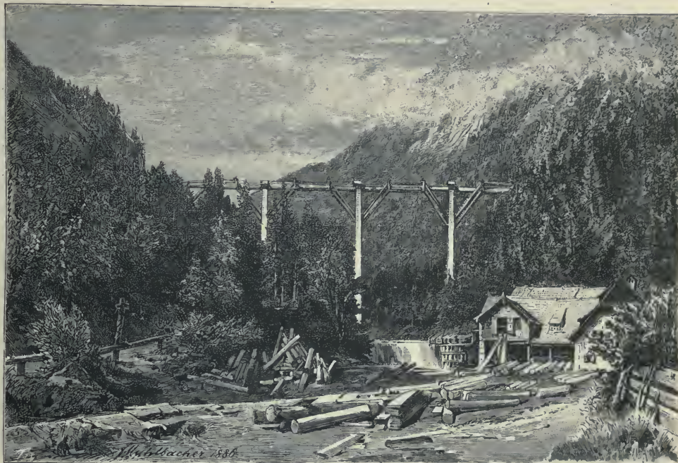
Gosauzwang mit der Salzleitung.
