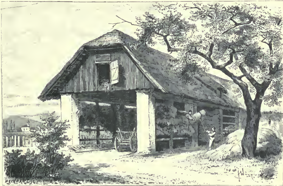
Trockenhaus „Garpse“ in Untersteiermark.
