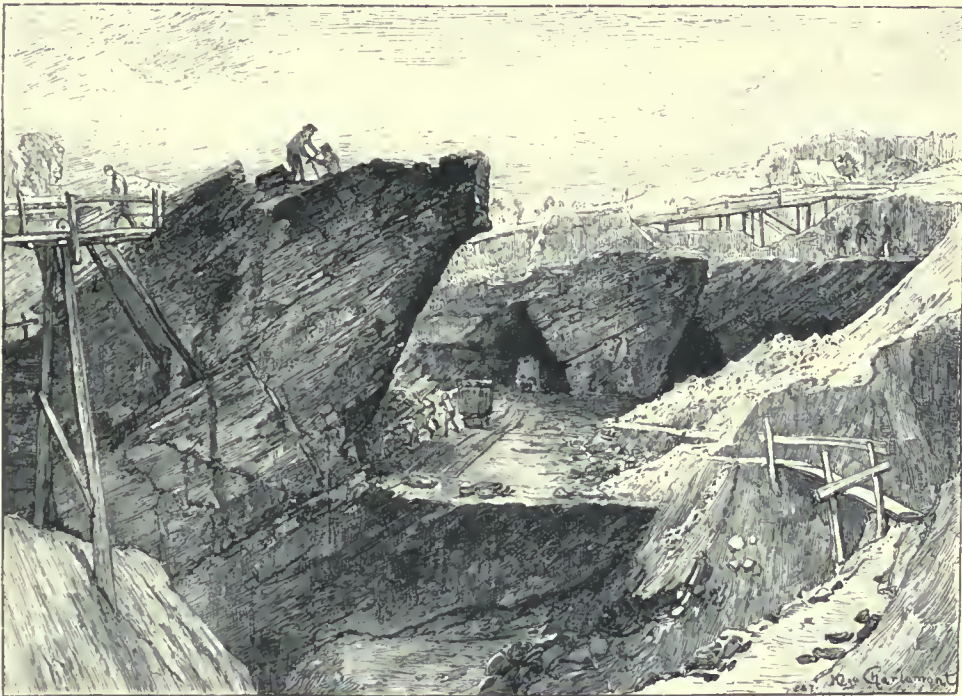
Kohlen-Tagbau zu Gradenberg.
