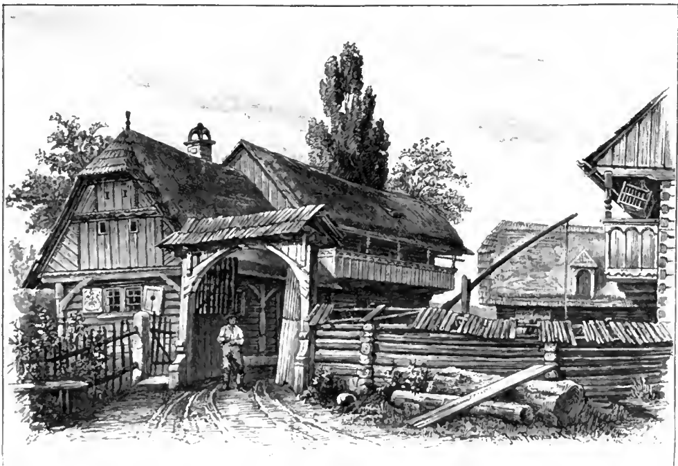
Holzgebäude bei Turnau.
