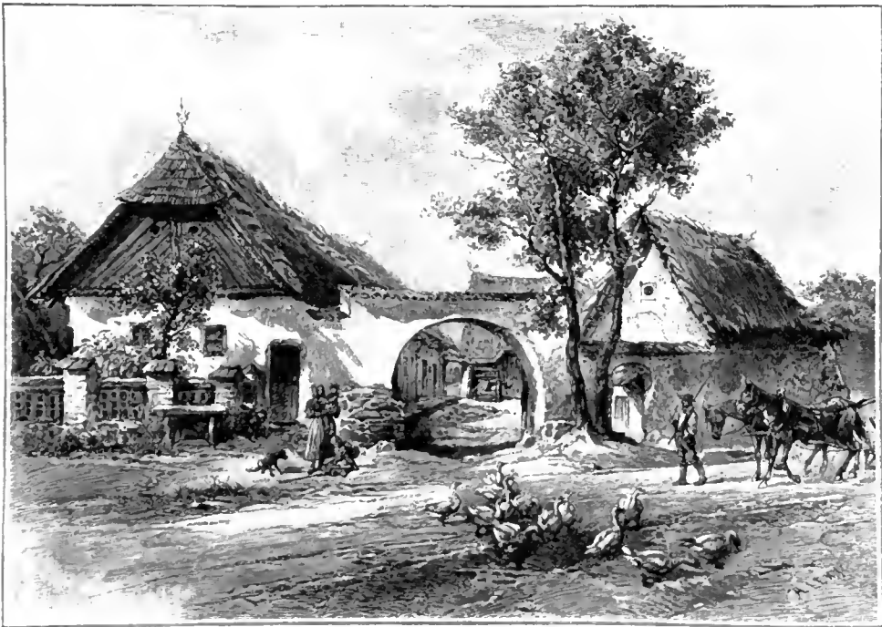
Torfbäude im südlichen Böhmen (Jaluži).
