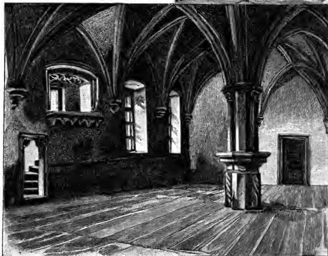
Die Kirche in der alten Burg und das alte Refectorium zu Klausenburg.
