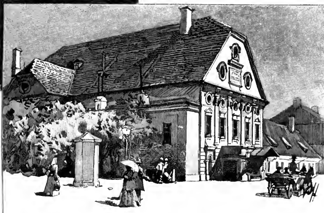
Klausenburg: Das Gebäude des Siebenbürger ungarischen Culturvereines. Das Nationaltheater.
