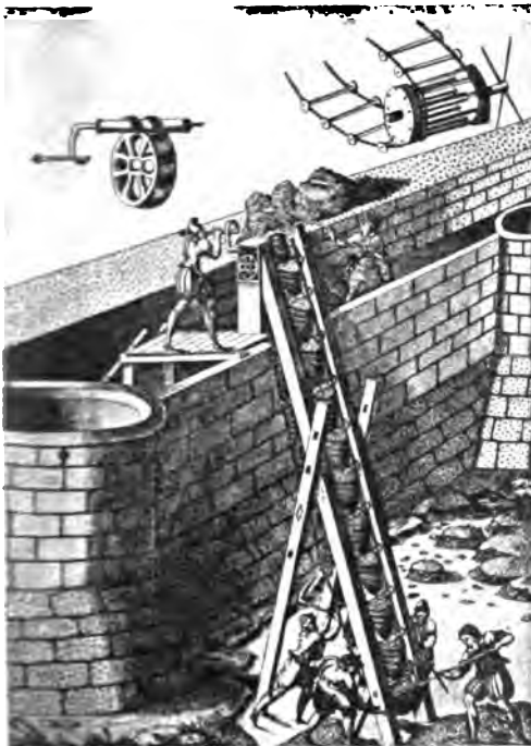
Abb. 49. Eimerkettenbagger um 1565. Kupferstich von R. Boyvin, aus Besson's Werk. Feldhaus, Technik.
