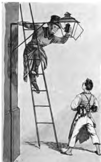
Abb. 237. Berliner Gaslaterne. Im Gegensatz zur Öllaterne sieht man an der Gaslaterne stets das aus der Erde heraufkommende Rohr. Aus Dörbeck, Berliner Witze (Nr. 5) um 1825.
