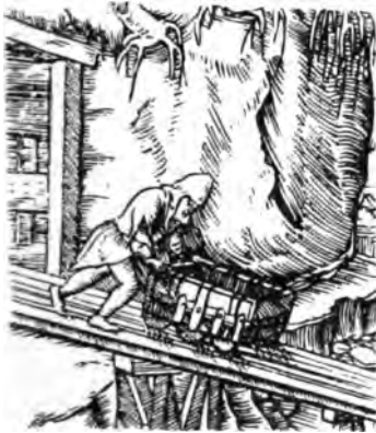
Abb. 246. Geleis aus Holz, nach Agricola, 1556.
