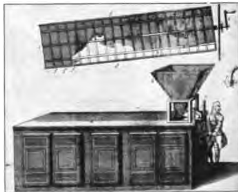
Abb. 691. Trommelsieb für Mehl, 1750.
