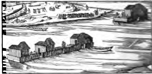
Abb. 804. Schiffsmühlen im Rhein bei Köln, 1531.
