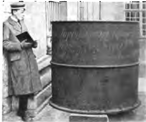
Abb. 129. Zylinder der ersten Dampfmaschine die in Deutschland dauernd (1715–1765) in Betrieb war.
