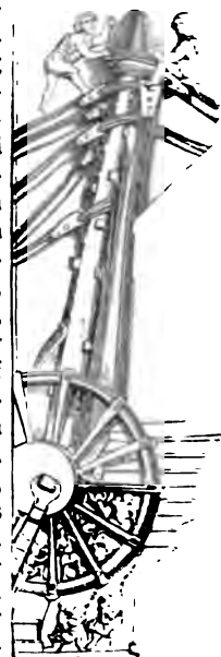
Abb. 352. Römischer Baukran mit Trettrommel.
