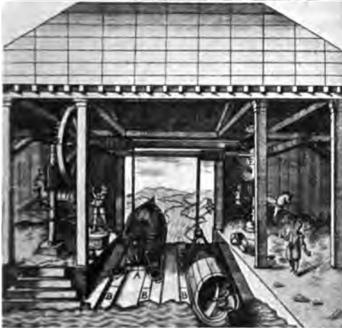
Abb. 612. Schiffezug am Brentakanal, nach Zonca, 1607.
