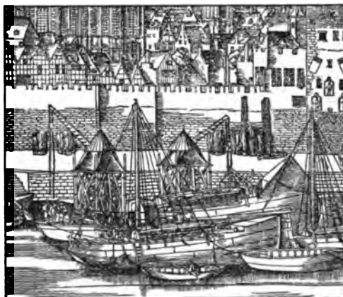
Abb. 604. Kranschiffe auf dem Rhein, 1531.
