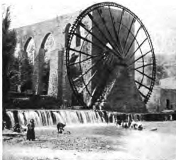
Abb. 546. Alte Radpumpe mit Wasserrad-Antrieb zu Hamâ in Syrien.
