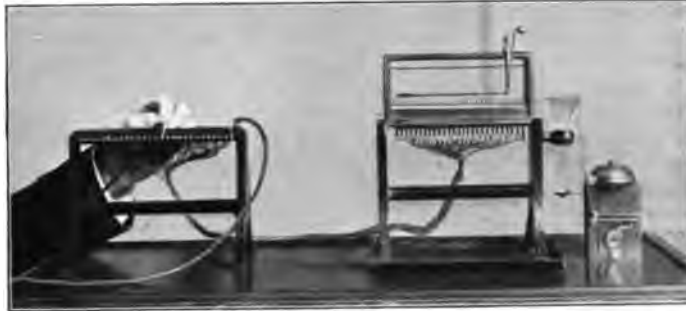
Abb. 747. Elektrischer Telegraph von Sömmering, links Geber, rechts Empfänger.
