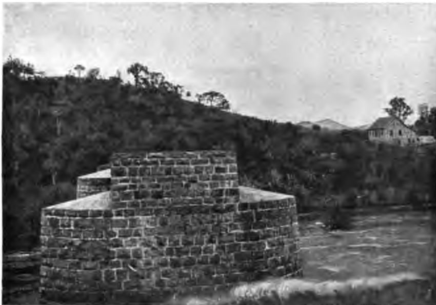
Abb. 28. Saltobrückenpfeiler bei Blumenau, seit Jahren vollendet, aber noch immer ohne Brückenbahn.
