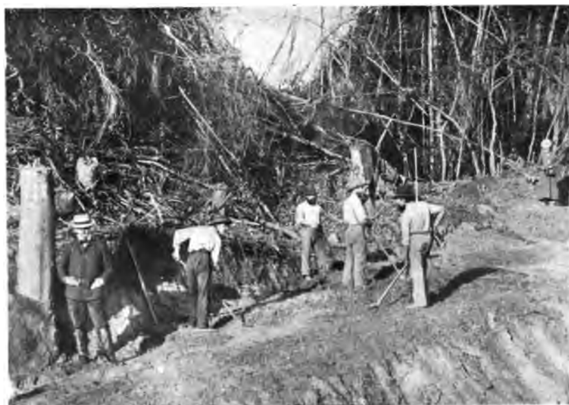
b. Wegbau durch Hansakolonisten in Neu-Bremen, acht Tage nach der Aufnahme von Tafel a, an der alten Fährstelle.
