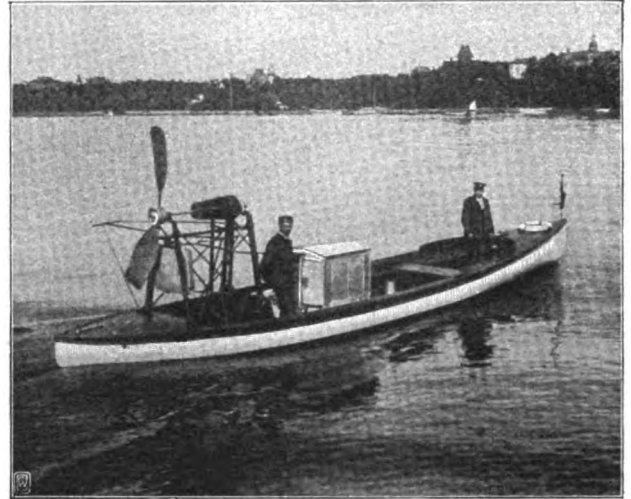
Der Luftschraubenmotor des Grafen Zeppelin.
