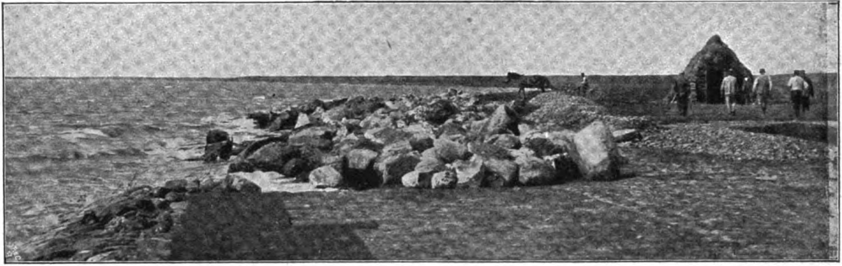
Steinlager zum Aufrichten des Deiches.
