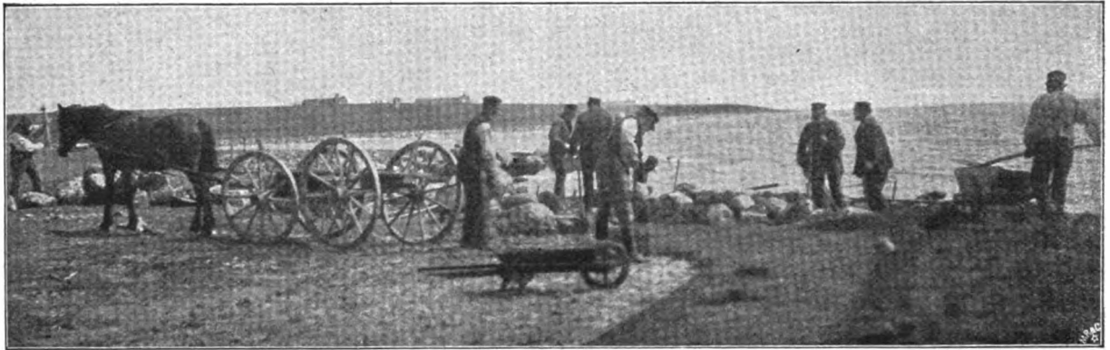
Die Steine werden dem Ufer vorgelegt.
