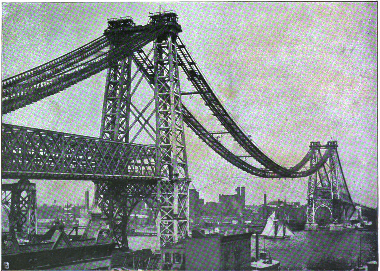
Die neue Drahtseilbrücke über den East River bei Newyork im Bau.
