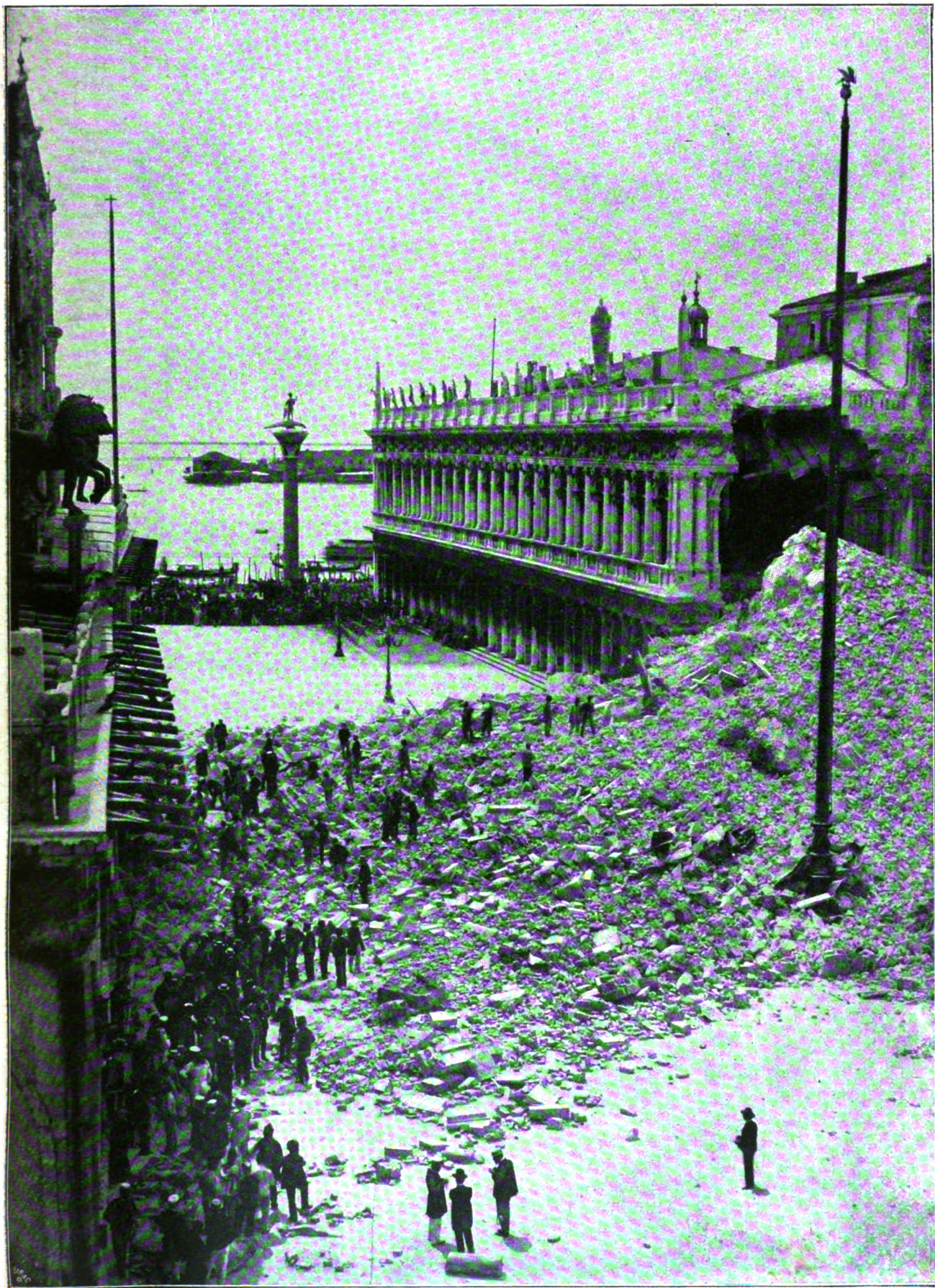
Die Trümmer des Glockenturms in Venedig.
