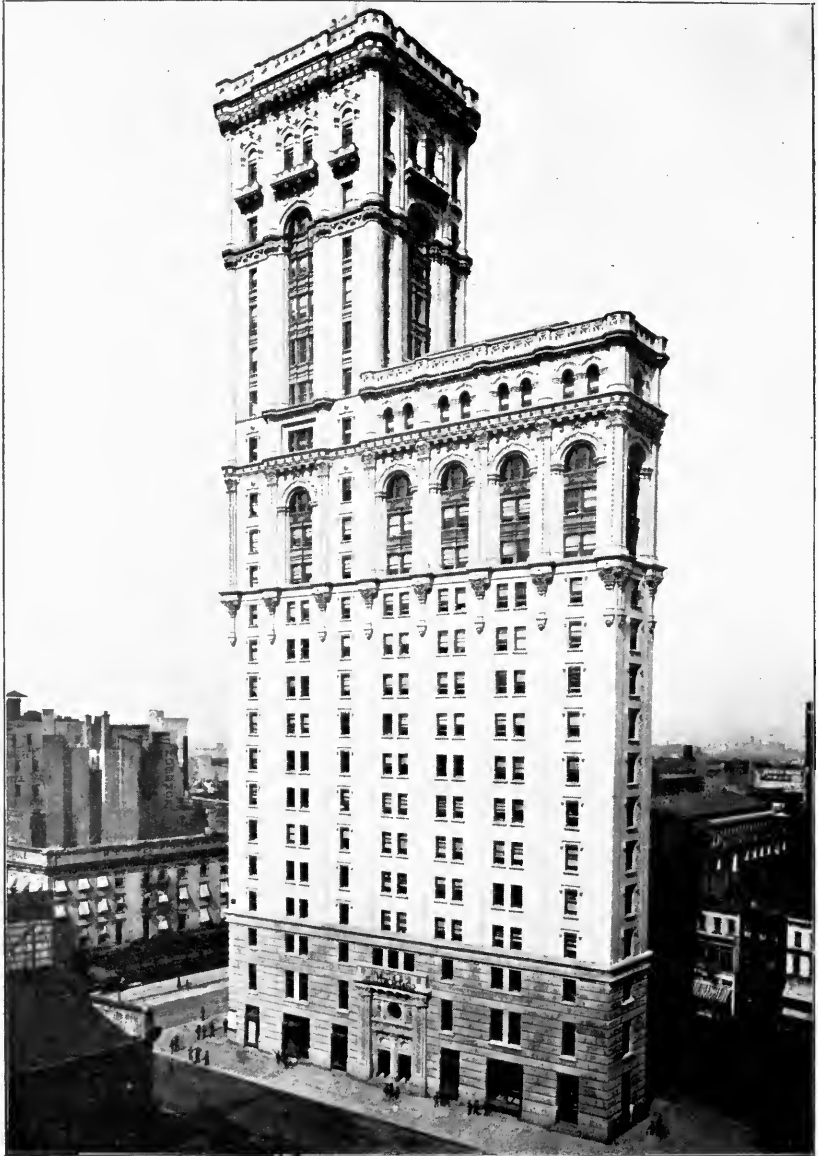
Das Gebäude der „Times“ in New York.
