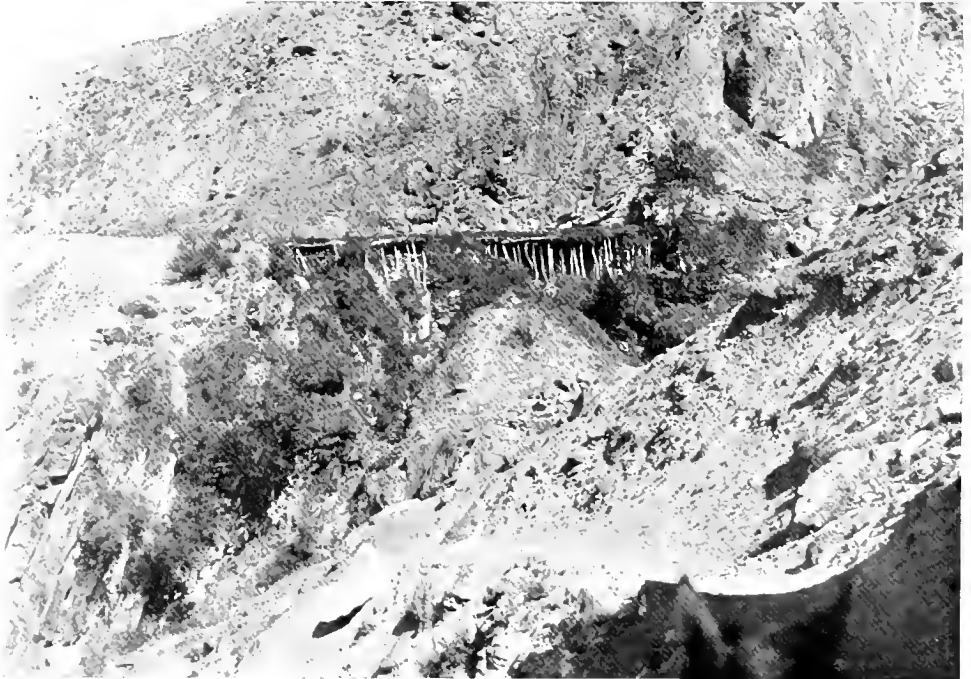
36. An Aqueduct; Upper Zarafshan.
