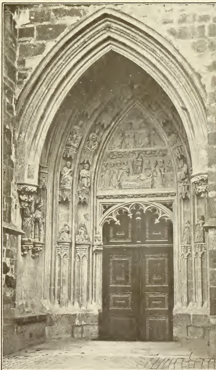
Nördliches Hauptportal des Domes. 1396.
