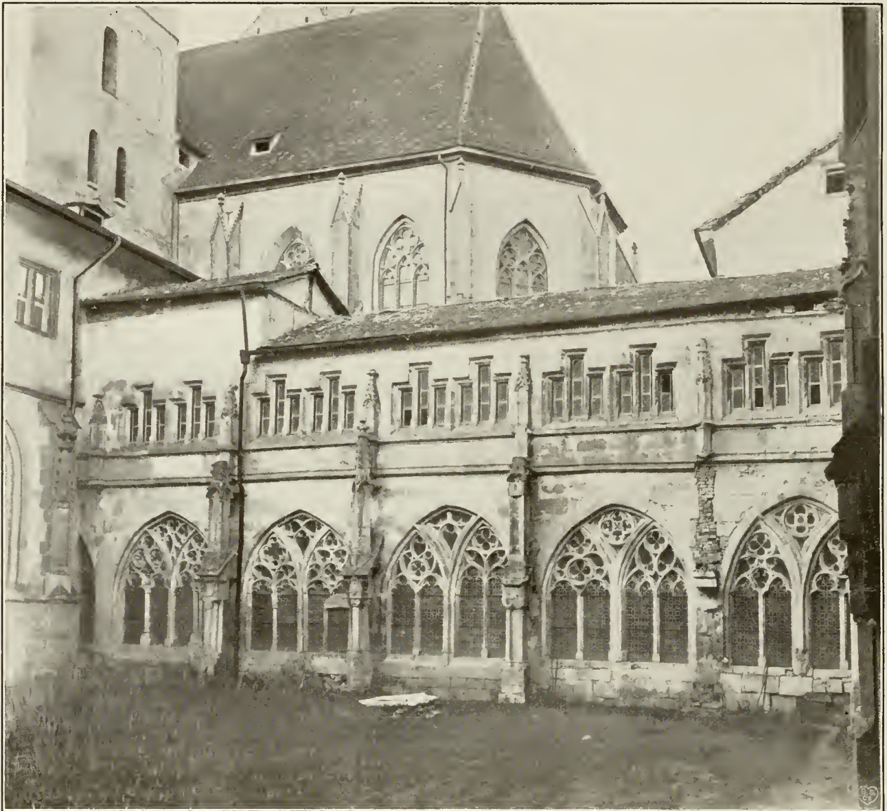
Außenansicht der nördlichen Halle des Kreuzganges. (Vor der Restauration.) Maßwerk, Streben und Obergeschoß aus der Mitte des 15. Jahrhunderts. Phot. Knauf, Eichstätt.
