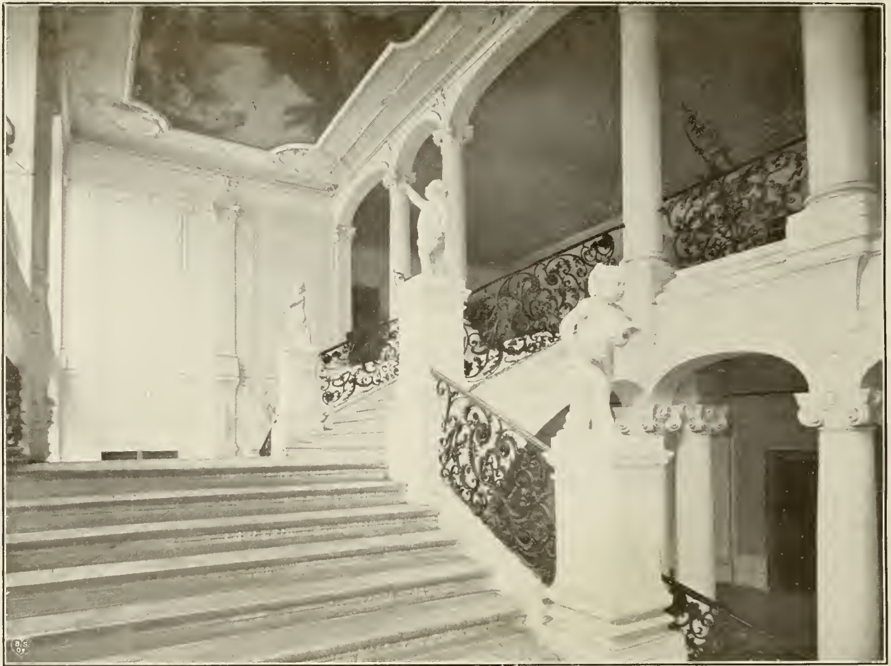
Stiegenhaus in der Residenz, Untergeschoß. (Nach Pedettis Plänen gebaut 1767). Phot. Hirschbeck.
