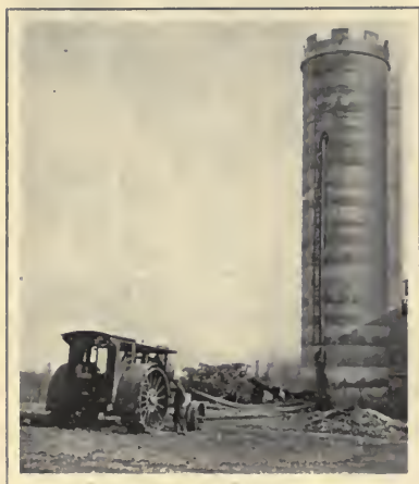
A CEMENT SILO.
