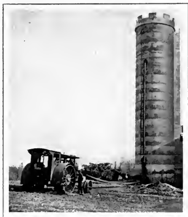
A CEMENT SILO.
