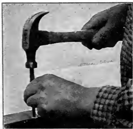
Fig. 27. Using a Nailset.
