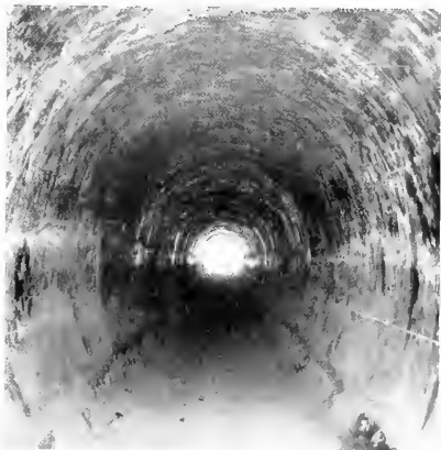
LA STESSA GALLERIA A LAVORI FINITI.
