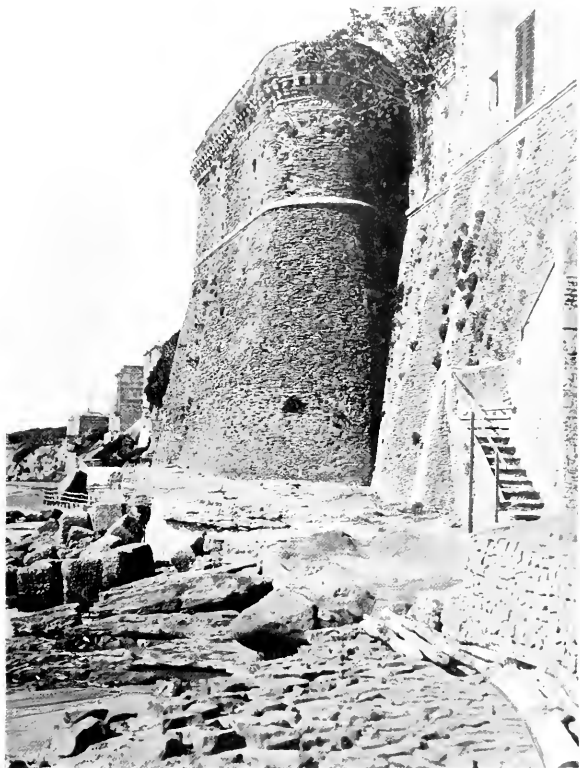
FORTE DI NETTUNO: LATO SUL MARE. (PARTICOLARE).
