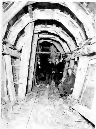
LA SECONDA GALLERIA-CANALE, O GALLERIA DI NOVE.
