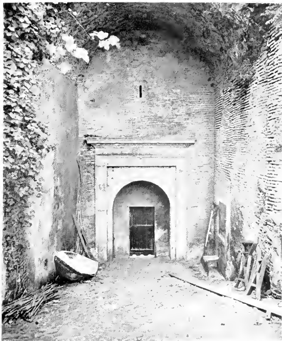
FORTE DI NETTUNO: PORTA DI DISCESA VERSO IL MARE.
