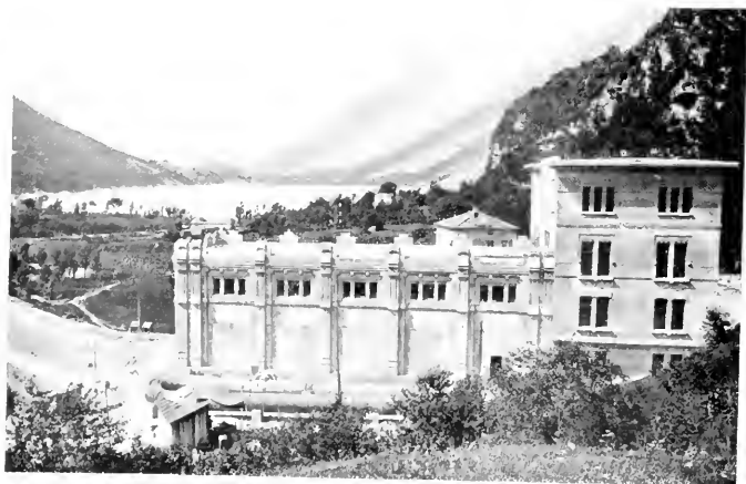
LA CENTRALE DI FALDATO A LAVORI FINITI
