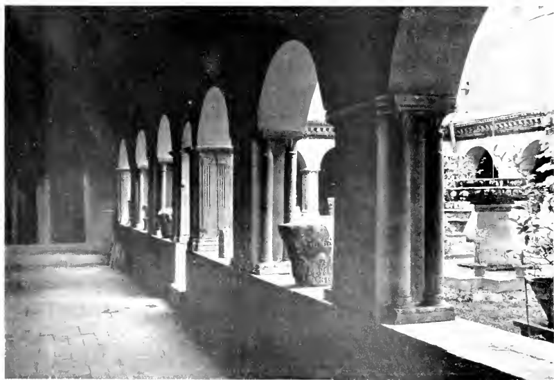
ROMA: CHIOSTRO DEI SS. QUATTRO CORONATI, DURANTE I LAVORI DI RESTAURO.
