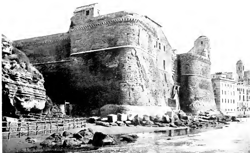
FORTE DI NETTUNO : BALUARDO NORD-OVEST.
