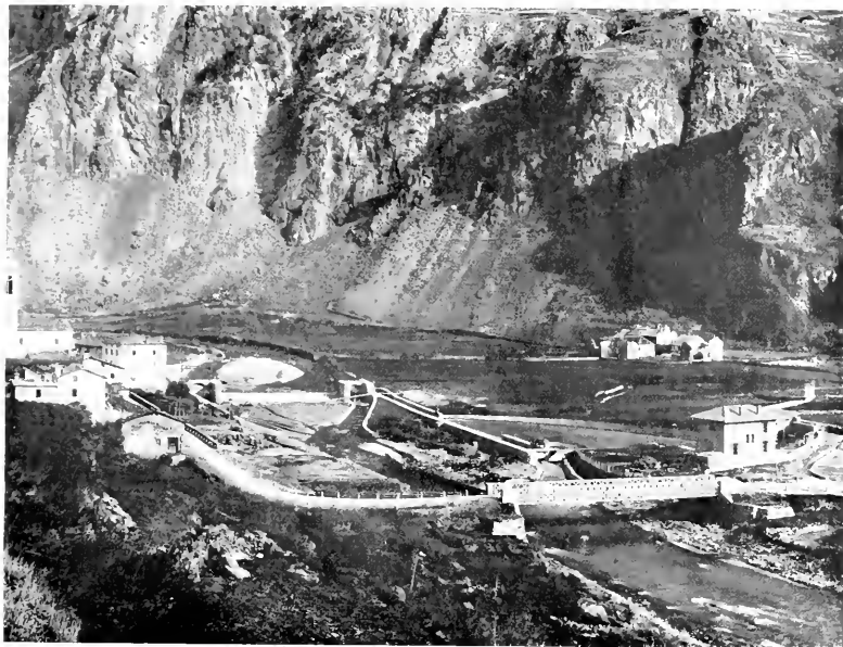
IMPIANTO IDROELETTRICO DI GROSSOTTO: LE OPERE DI PRESA.
