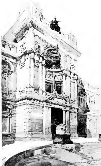
PALAZZO DEL RETTORATO: PARTICOLARE DEL PROSPETTO.
