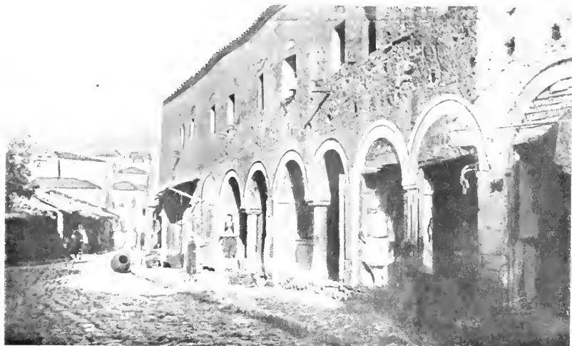
ANTICA COSTRUZIONE VENEZIANA IN VALLONA.
