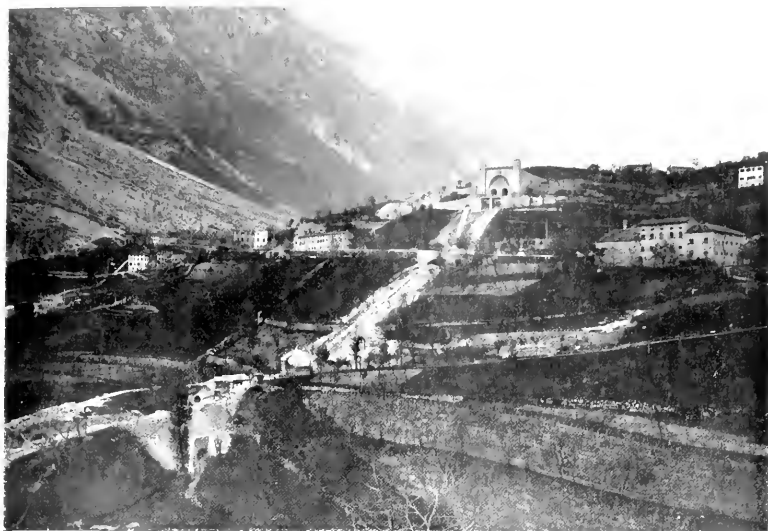
IL BACINO DI CARICO E LA TUBAZIONE DEL SECONDO SALTO VISTO DA VALLE.
