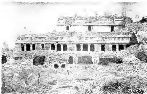
IL « TEMPIO MAYOR » A TRE PIANI DI SAVIL. ALA DESTRA DELLA FACCIATA SUD.
