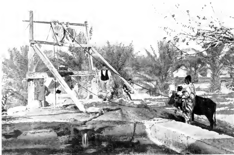
POZZO A DUE CARRUCOLE CON ARMATURA IN LEGNO PRESSO TRIPOLI.
