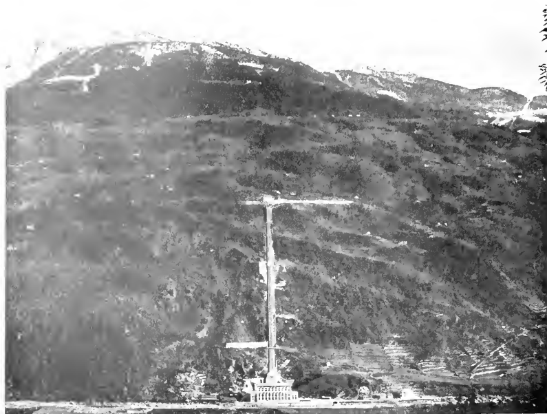
IMPIANTO IDROELETTRICO DI GROSSOTTO. LA CONDOTTA FORZATA.
