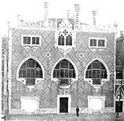
FACCIATA DELLA « CASA DAI TRE OCCHI » — VENEZIA. ALLA GIUDECCA.
