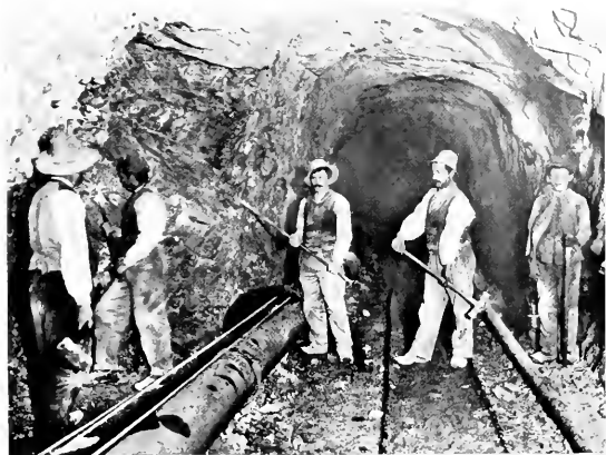
L'ALLARGAMENTO DELLA PRIMA GALLERIA.
