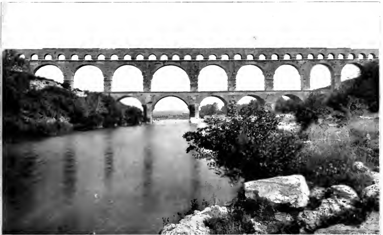
PONT DU GARD, NÎMES (NEMAUSUS).
