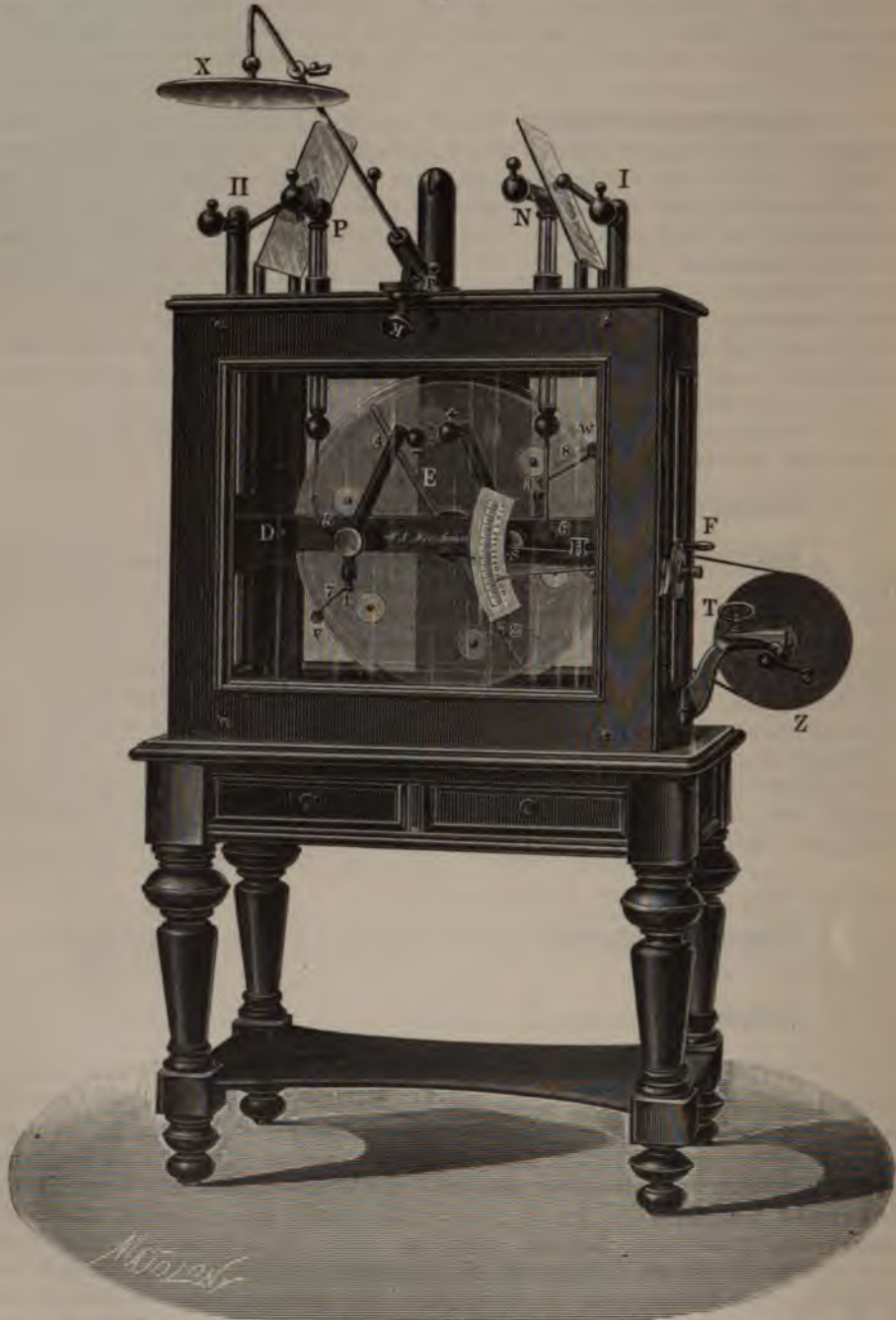
Influenzmaschine nach Eulenburg-Hirschmann, im Glaskasten, mit Kurbel zum Handbetrieb. Ueber dem Kasten die Säulen I, II , die Ableitungen P, N mit den Franklin'schen Tafeln und die Kopfplatte X .
