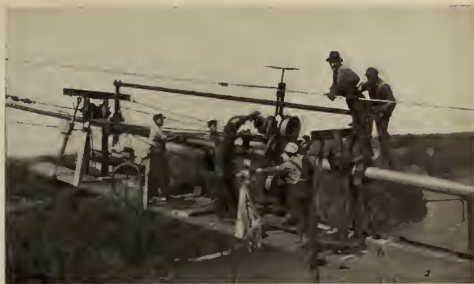
Fig. 8—Machine Wrapping the Cable
