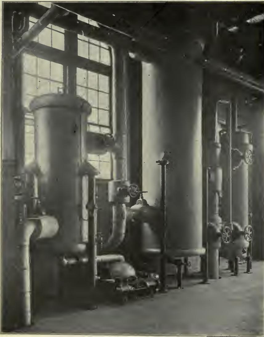
HEATERS IN POWERHOUSE FOR HOT-WATER HEATING SYSTEM.
