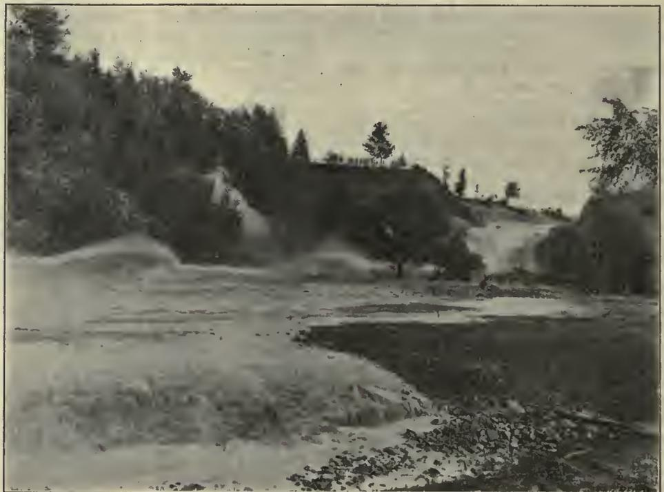
BREAK IN RESERVOIR BEFORE COMPLETION OF WASHOUT.
