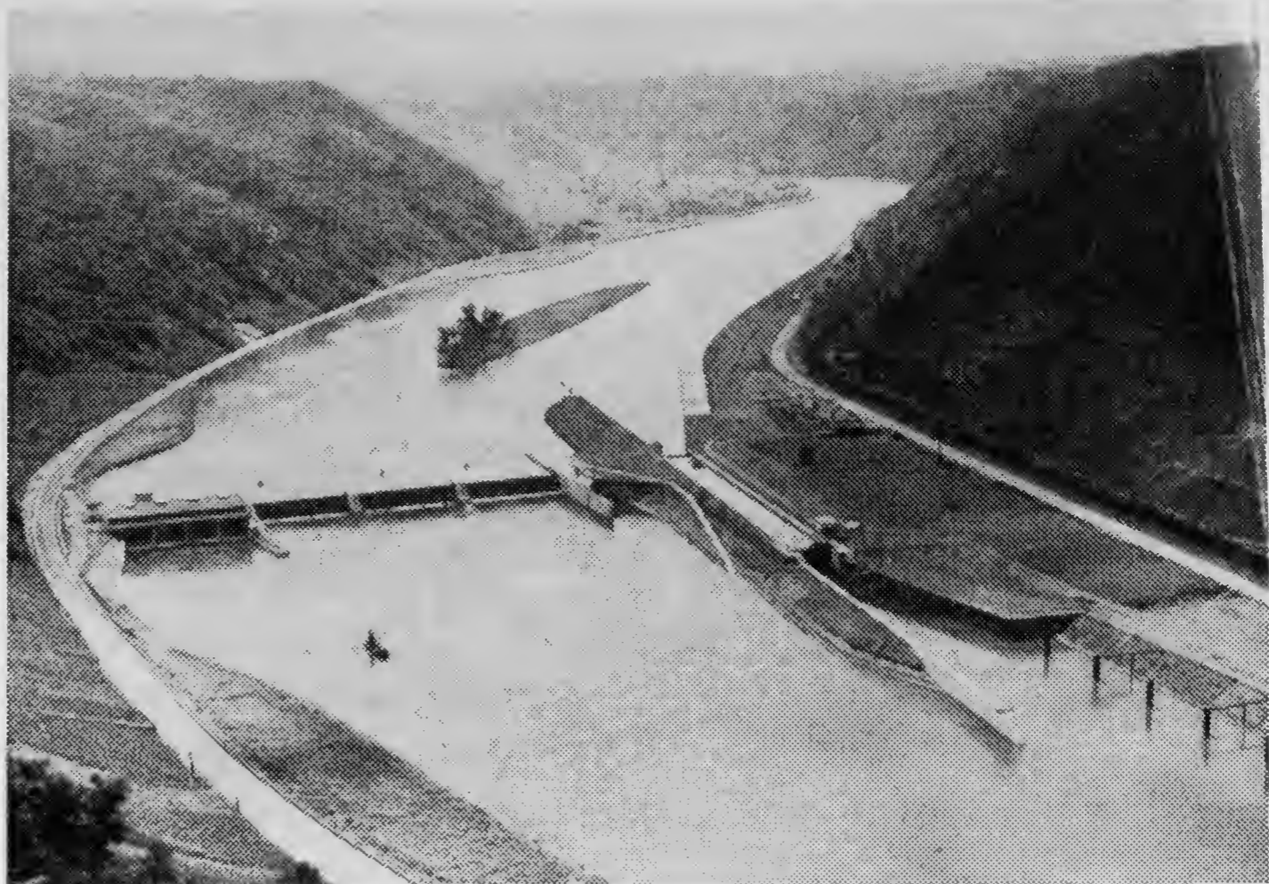
A barragem de Lehmen no Mosela
