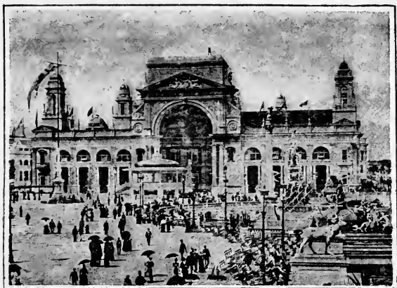
PALACIO DE LA ELECTRICIDAD
