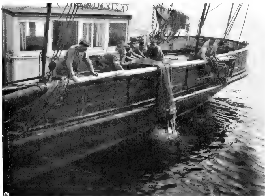
44. — Exploration de la mer. Instrument spécial. Pêche au chalut à fers déclinants. Rentrée du sac facilitée par l'application des fers contre les parois, la gaule se plaçant contre la lisse de bastingage.
