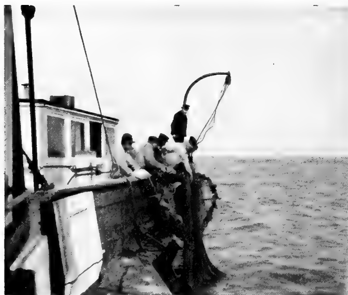
46. — Exploration de la mer. Chalut ordinaire, à fers non déclinants.
