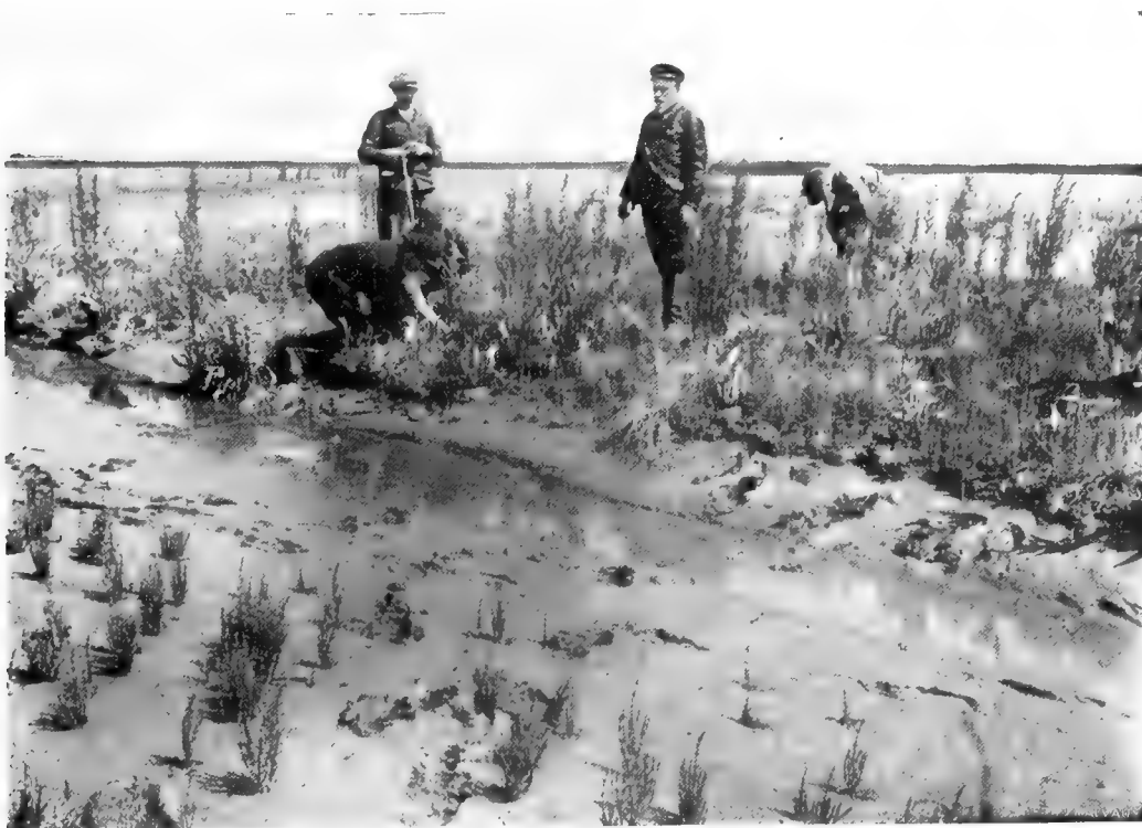
7. — Exploration de l'Escaut maritime.
