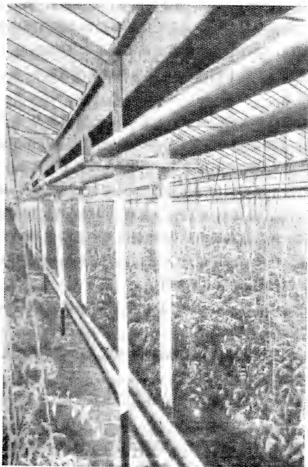
圖 15 烏赫托姆区“第三个五年計劃”集体農庄的溫室的内部情形,这个溫室是用工業企業的廢热加溫的。
