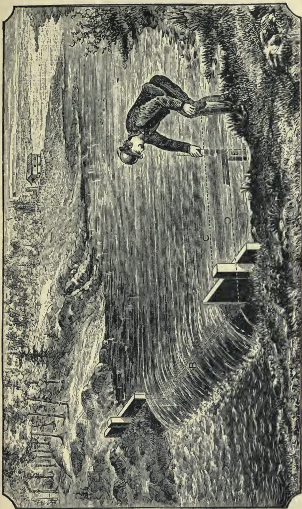
FIG. 42—RECTANGULAR WEIR.
