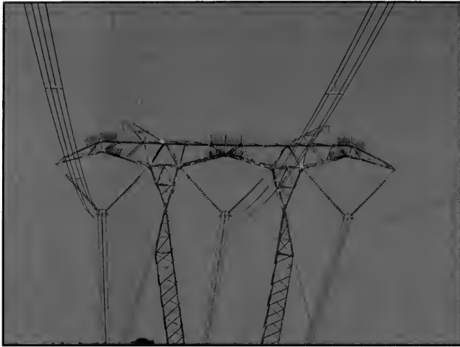
Figure 6: Des “dispositifs de protection des oiseaux en plastique” sont installés sur les tours de transmission pour empêcher les oiseaux de se percher
