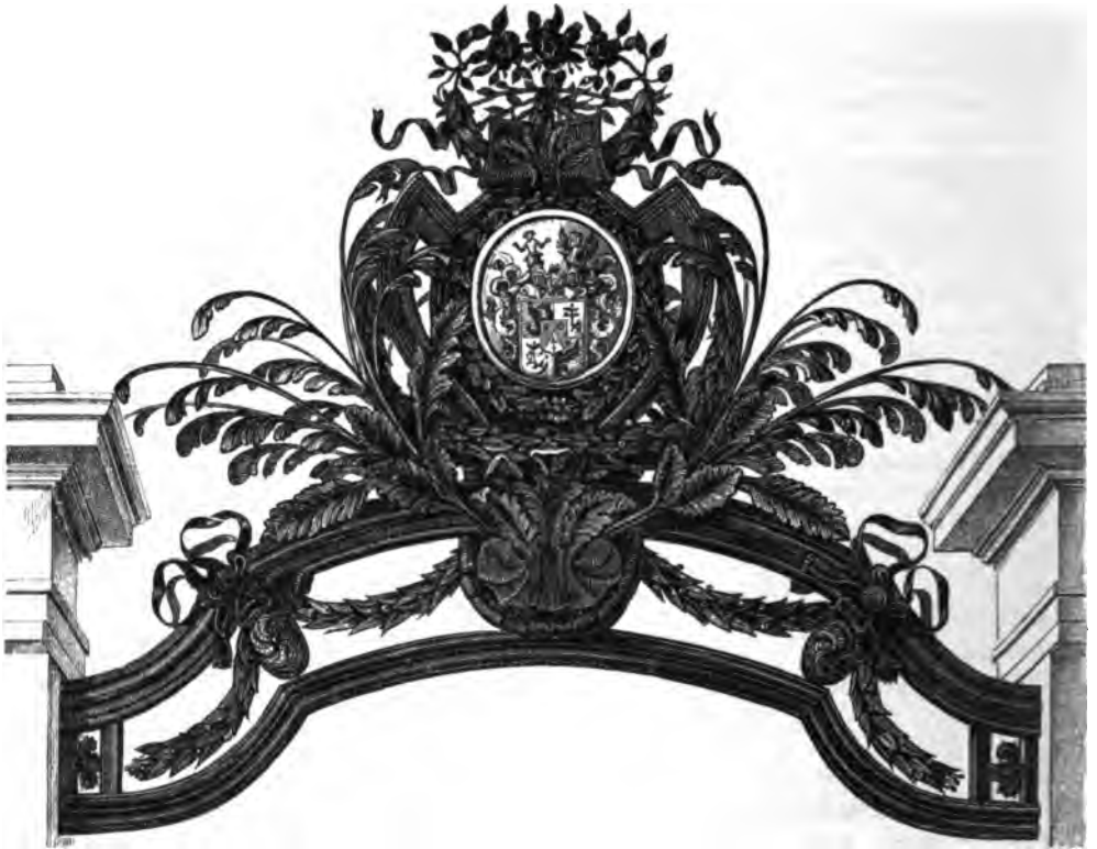
[Schmiedeeiserne Bekrönung vom Gitter-Portal des ehemals Schüle'schen Fabrikgebäudes in Augsburg. Das Schüle'sche Wappen in der Kartusche aus getriebenem Kupfer und vergoldet. Augsburger Arbeit, ca. 1775. Spannweite 3,33 m.
