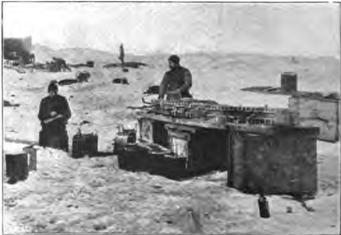
Rensning af accumulator-batteriet før det staves bort.
