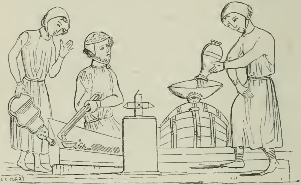
Fondeurs de métaux.
