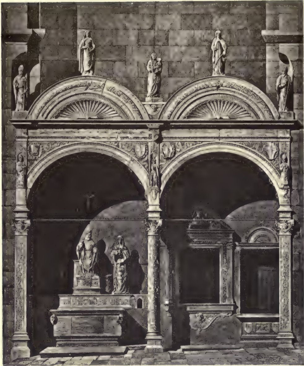
MARSEILLE, St. Lazare. Franz Laurana und Sumalvito, Doppellaube. Gesamtansicht (Bariatier-Feissat, Marseille)
