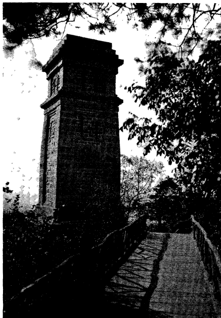
Der Bismarckturm auf dem Schloßberge bei Freiburg. Aufnahme von G. Köbke, Freiburg.
