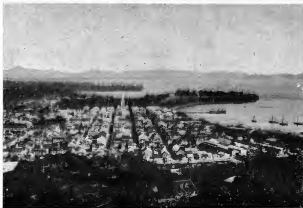
FIG. 41. — Fort de France.
