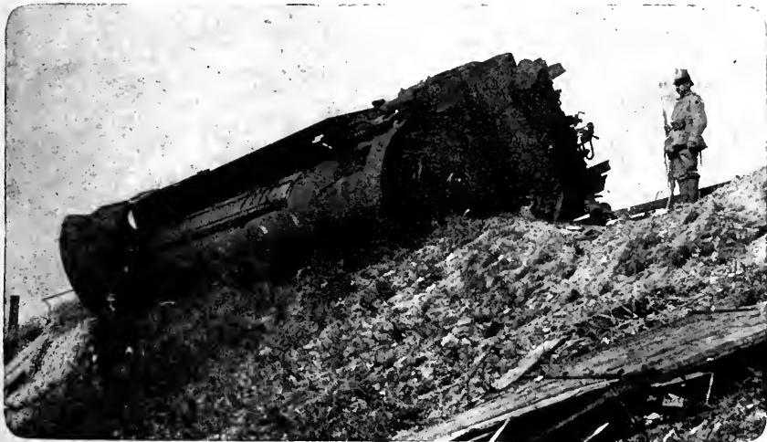
An der russischen Grenze. Deutsche Lokomotive, von den Russen zum Entgleiten gebracht.
