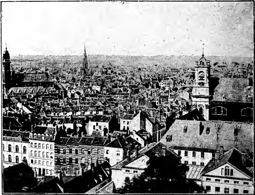
Ansicht von Brüssel.
