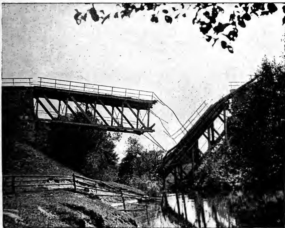
Von den Deutschen gesprengte Eisenbahnbrücke in Frankreich.
