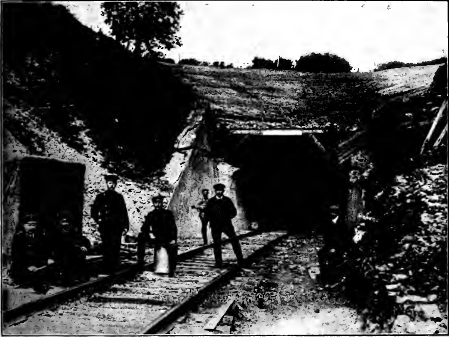
Ein belgischer Eisenbahntunnel, der von den Belgiern zur Behinderung der deutschen Bahntransporte zerstört und von den Deutschen binnen kurzer Zeit wiederhergestellt wurde.
