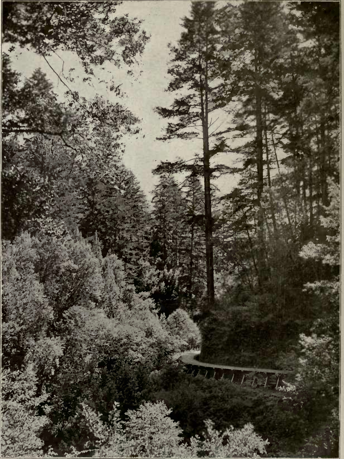
PILARCITOS SIDE FLUME.
