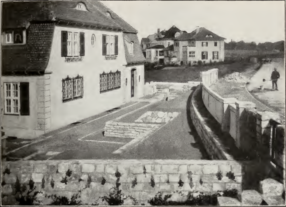
84 Zurückhaltung des Geländedruckes durch Erdstufen und Mauern
