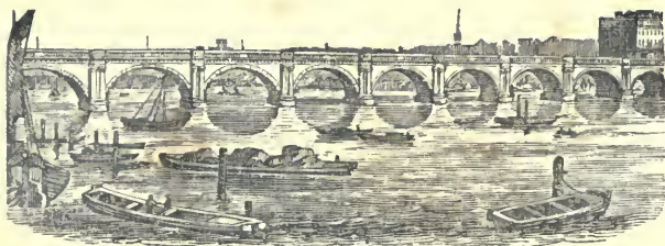
Waterloo Bridge, London.
