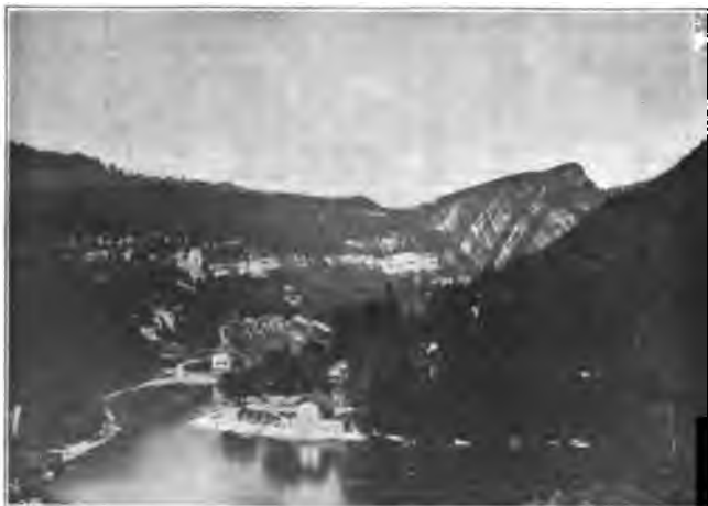
Der Felsstaudamm des Lac des Brenets. (Abgedämmter Doubs).
