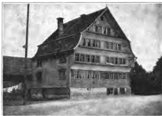
Kanton St. Gallen : Haustypus in Gossau.
