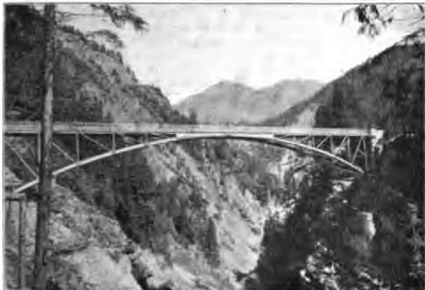
Rhein: Brücke über das Versamertobel.
