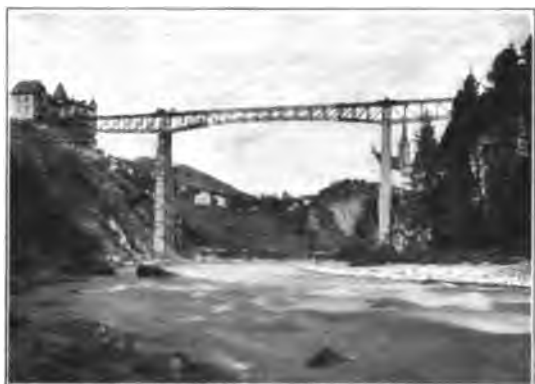
Neue Innbrücke bei Schuls.
