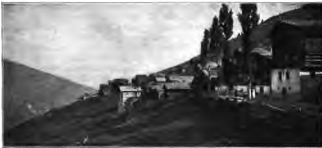
Saint Martin (Wallis) von Südosten.
