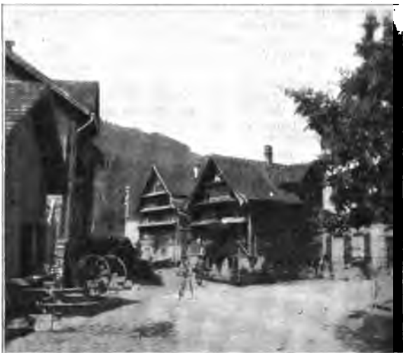
Kanton St. Gallen : Haustypus in Wattwil (Toggenburg).
