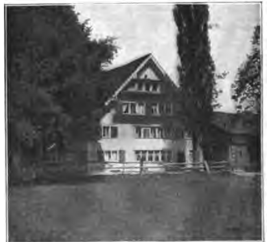
Kanton St. Gallen: Haus im Paradies bei der Stadt St. Gallen.
