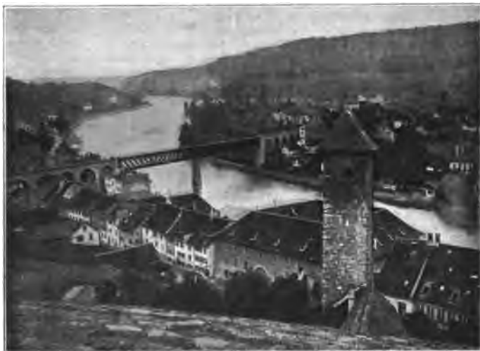
Rhein und Eisenbahnbrücke oberhalb Schaffhausen.
