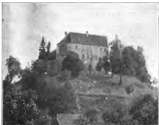
Reiden (Kant. Luzern): Alte Johanniterkomthurei, von Norden.
