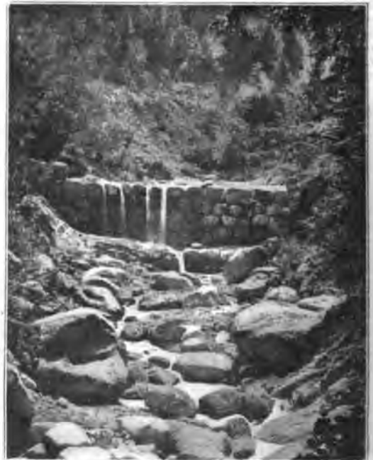
Spreitenbach bei Lachen. (Hauptbach nach der Verbauung.)
