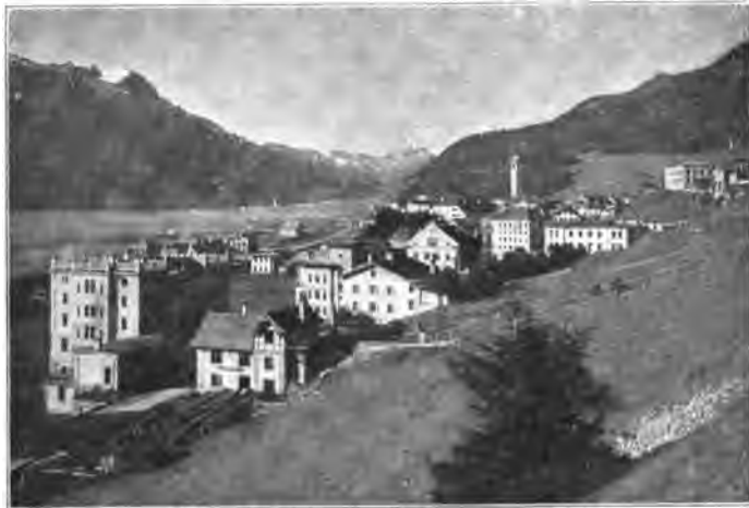
Samaden von Nordosten.
