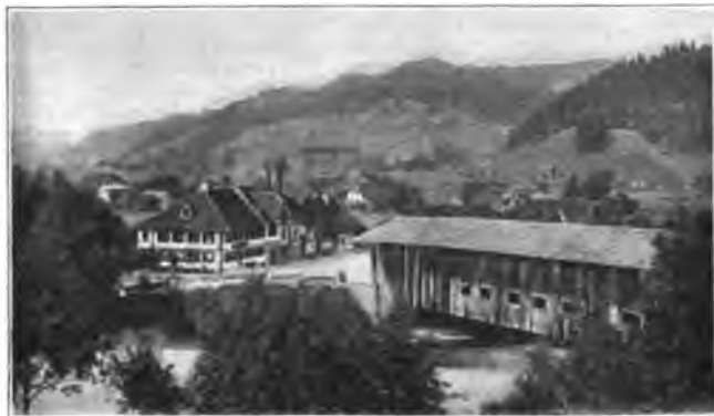
Brücke über die Emme in Schüpbach.
