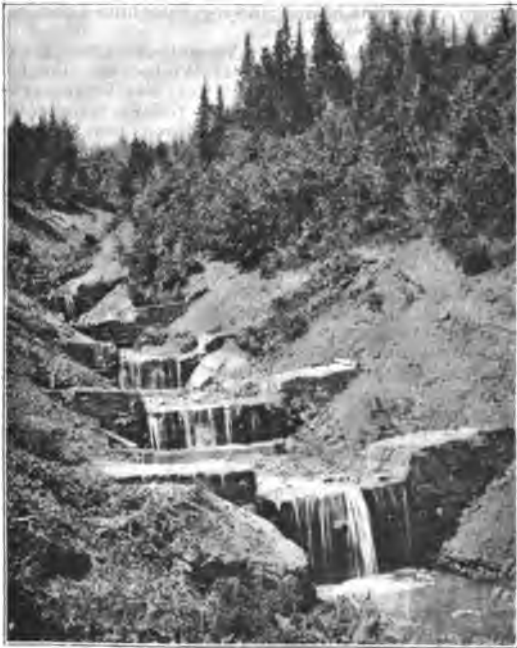
Thalsperren in der Schwandchlieren bei Alpnach.
