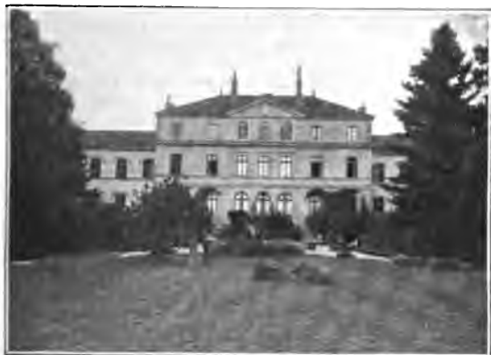
Mittelbau der Anstalt Préfargier.
