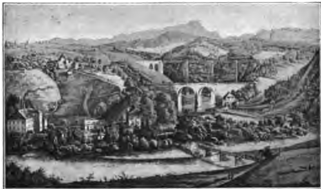
Kanton St. Gallen: Sitterbrücken.
