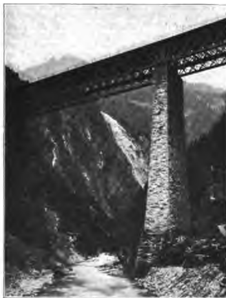
Gotthardbahn : Grosser Viadukt bei Amstäg.
