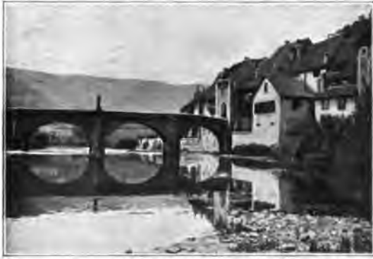
Doubsbrücke in Saint Ursanne.
