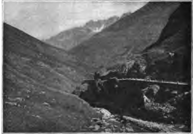
Engpass von Marengo an der Strasse über den Grossen St. Bernhard.
