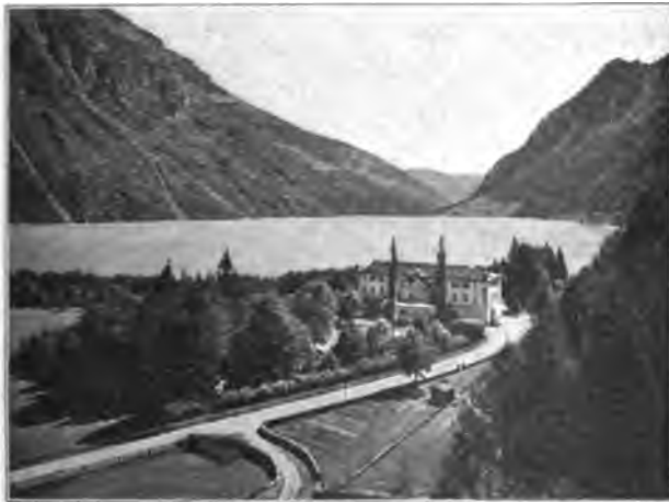
Puschlaversee und Le Prese von Nordwesten.
