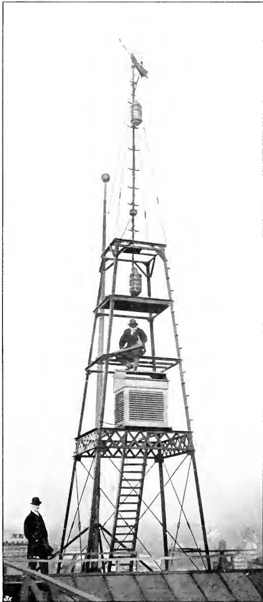
Fig. 4. Anemometergerüst und Thermometerhütte zu Buffalo.
