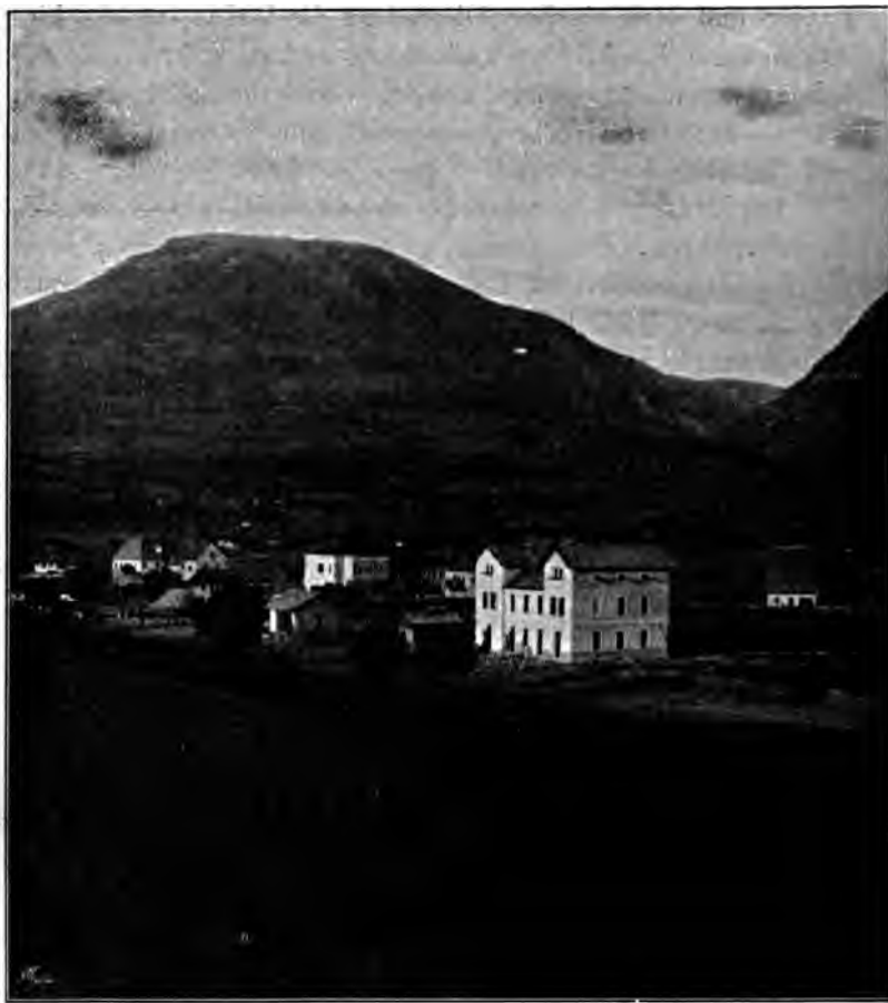
Abb. 47. Die Ebene von Bu Die hohen Berge im Hintergrunde, links der Kalin vrh, rechts der Rudin, bes Binnenlandtertiär und Diluvium, welches letztere auch die Eben
