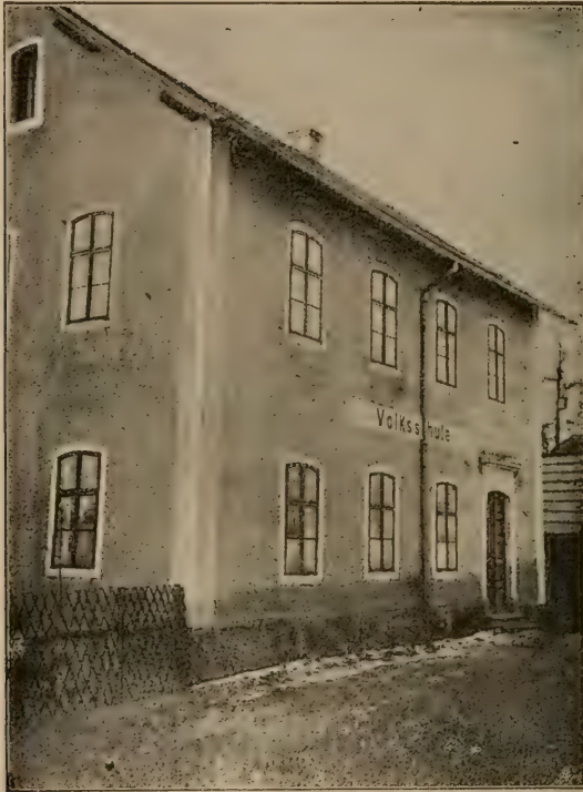
Volksschulgebäude im Stadttheile Grund No. 481.
