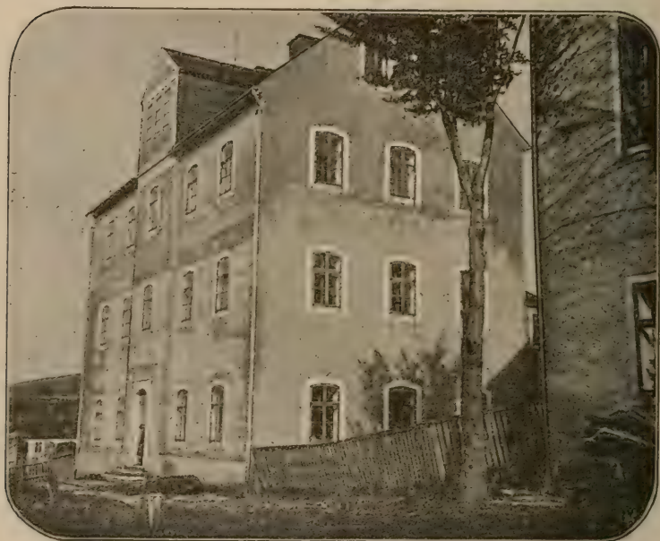
Volksschulgebäude No. 482 in Neugeschrei.
