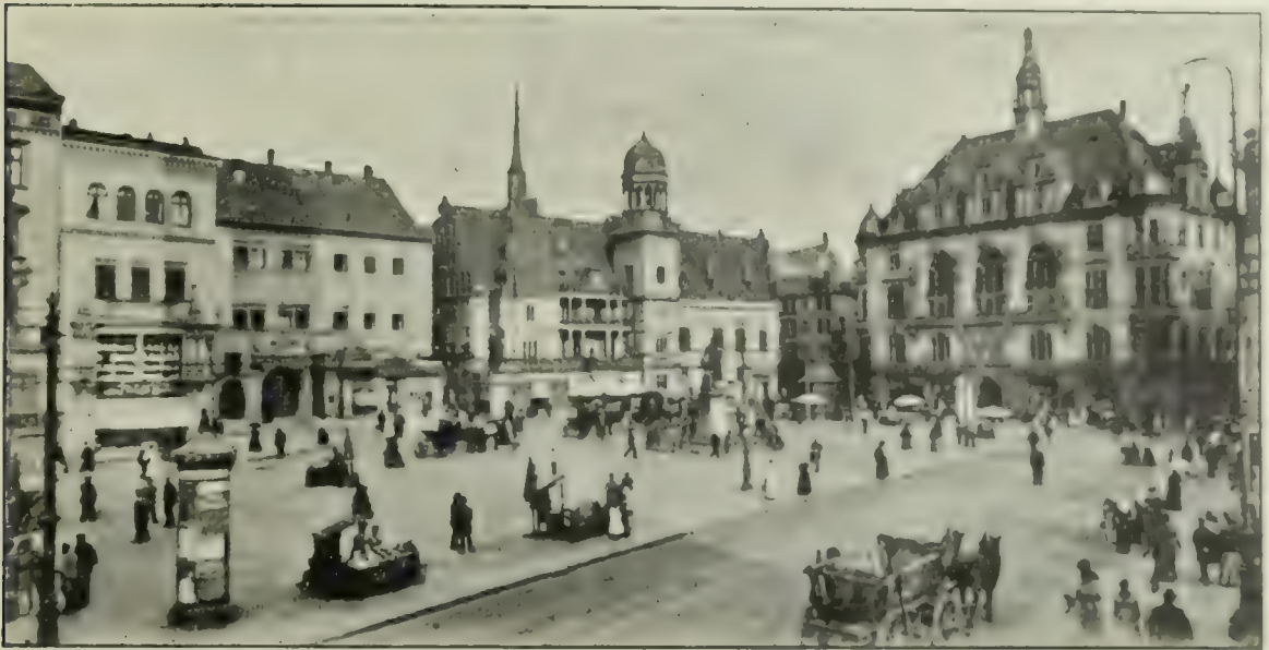
„Wage“ und Rathaus in Halle a. S. im heutigen Zustande.
