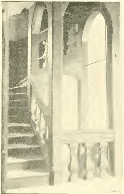
SCALA DELLA CASA IN VIA DEI BLANCS-MANTEAUX.
